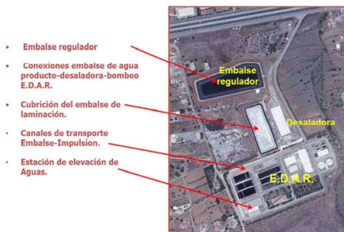
Figura 8: Vista general de la Instalaciones de Arco Sur.
