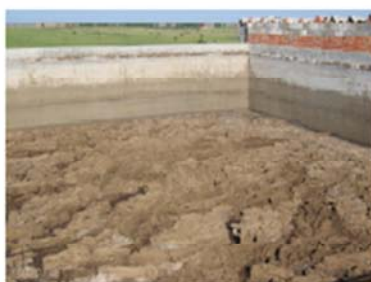
Figura: Balsa de almacenamiento de purines cubierta con la costra natural
