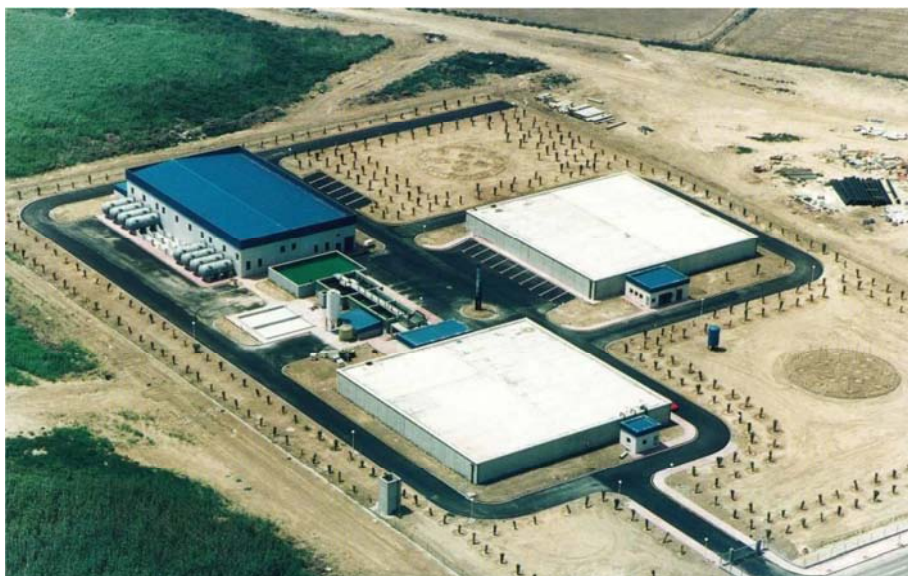
Figura 7: Vista general de la Planta Desalobradora de El Mojón
