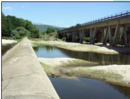
**PROBLEMÁTICA:** Azud para evitar la socavación de los pilares del viaducto de la N-502 sobre el río Tiétar, que no permite el paso de peces. Se constata la presencia de anguila de repoblación, boga, cacho, calandino, colmilleja y barbo
