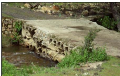
**PROBLEMÁTICA:** Azud de 7 m de altura para suministro de agua a una minicentral hidroeléctrica, interrumpe la continuidad longitudinal de este río en el que aún existen poblaciones de trucha autóctona. Aguas arriba del azud existe una obra de paso sobre tubos que también supone una barrera
