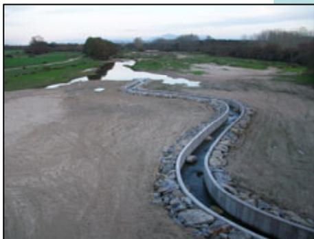
**SOLUCIÓN:** En vez de una escala en saltos, se proyecta una obra “singular”: una rampa en el propio cauce del río, excavada en los sedimentos del vaso del azud, que permeabilice el río y no fomente la erosión de los pilares llevando la entrada a la rampa aguas arriba
