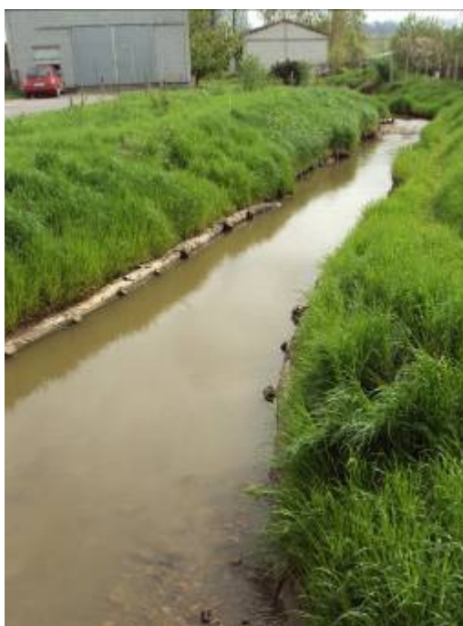
Foto 7. Troncos protegiendo la base del talud en actuación de arroyo de Vega del Rey (Cacabelos, León).
