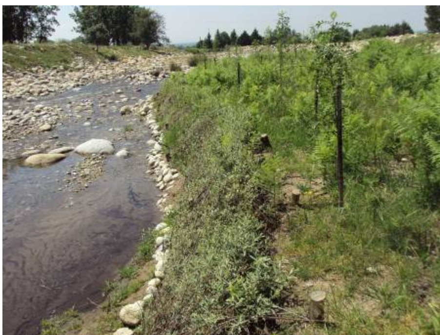
Foto 1. Cobertura de ramas en actuación de garganta de Chilla (Candeleda, Ávila).
