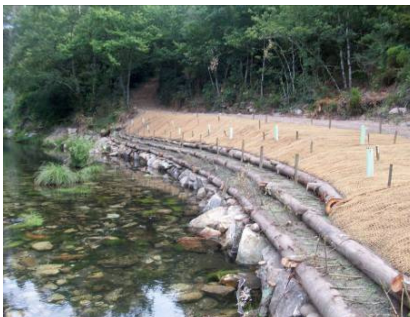
Foto 5. Muro Krainer recién ejecutado en actuación de río Tamuxe (Oia, Pontevedra).
