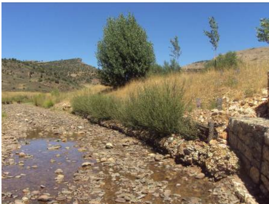
Foto 4. Gavión cilíndrico flexible en actuación de río Linares (Riba de Saelices, Guadalajara).
