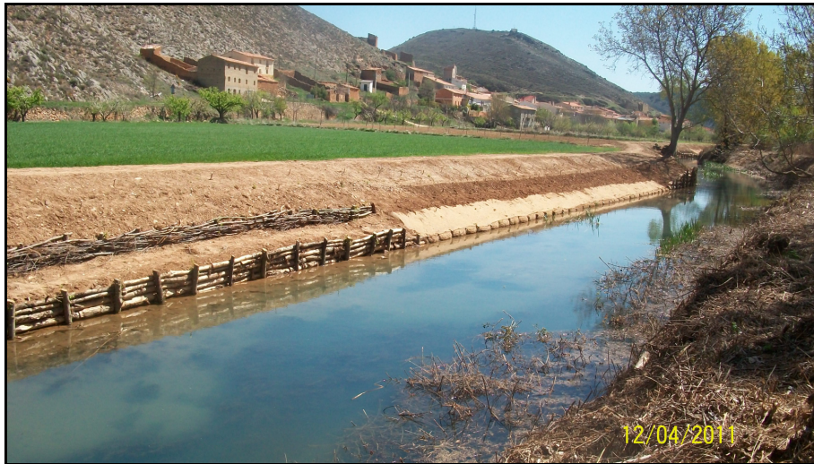
Fotografía 8.- Obras de bioingeniería para la restauración ambiental del río Piedra a su paso por el T.M. de Cimballa (Zaragoza)
