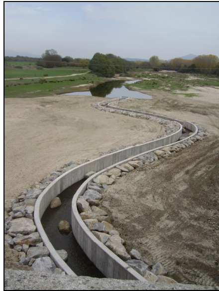
Fotografía 5.- Creación de rampa para peces en Arenas de San Pedro (Ávila)
