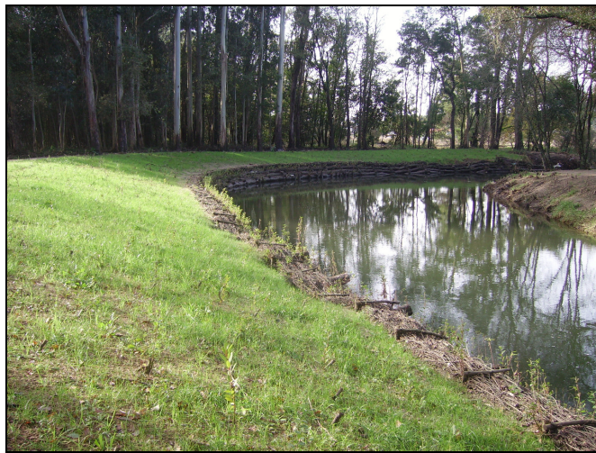
Fotografía 2.- Estabilización de márgenes mediante bioingeniería en el Río Tamuxe en O Rosal (Pontevedra)
