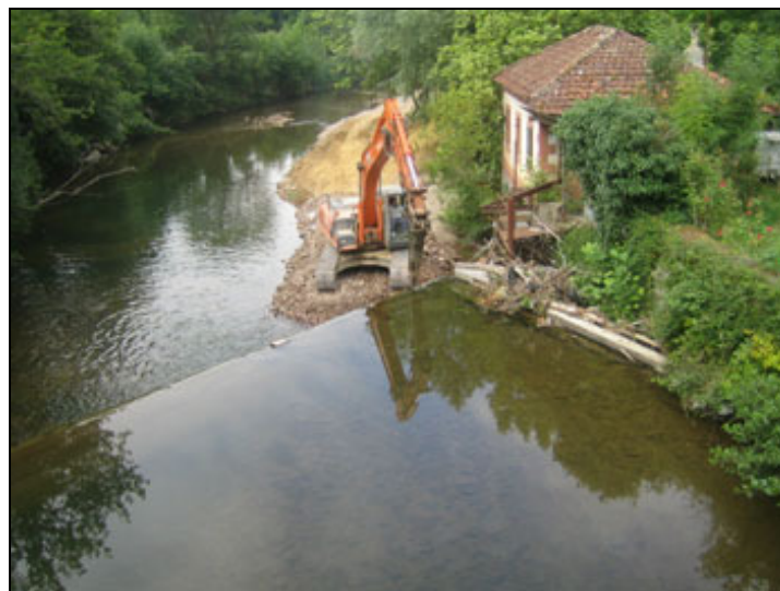
Fotografía 4.- Demolición del azud de Elizondo sobre el río Baztán, Navarra.
