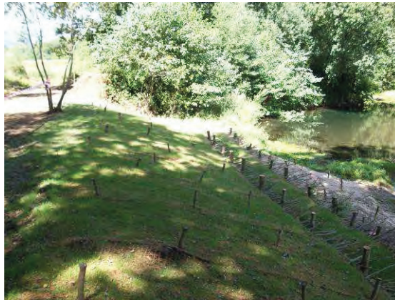
Figura 3. Estaquillado sobre geomalla Fuente: Elaboración propia
