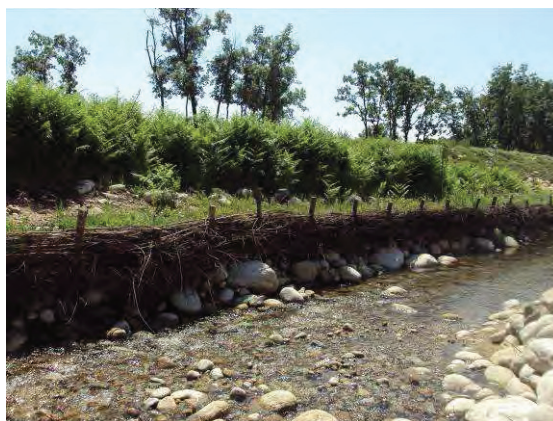
Figura 5. Fajina de empalizada trenzada Fuente: Elaboración propia
