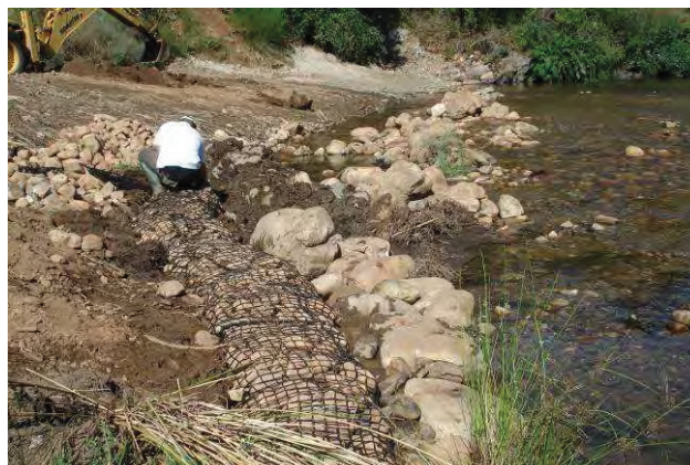
Figura 7. Colocación de gavión cilíndrico
