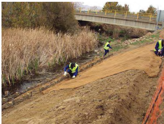
Figura 8. Operarios instalando cubrición orgánica Fuente: Elaboración propia
