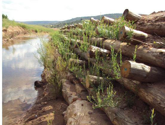
Figura 6. Empalizada de defensa reforzada
