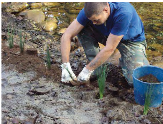
Figura 9. Colocación de vegetación en rollo estructurado Fuente: Elaboración propia
