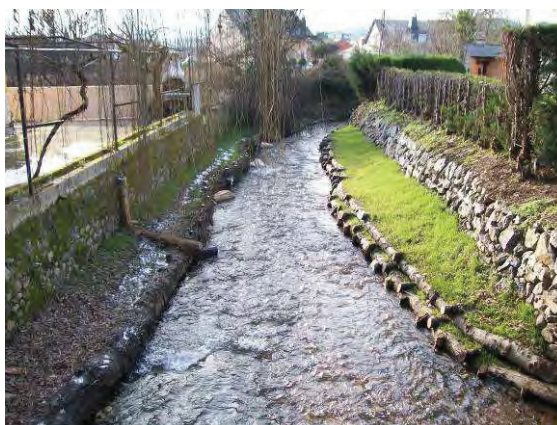
Figura 10. Utilización de troncos de árboles para proteger el talud Fuente: Elaboración propia
