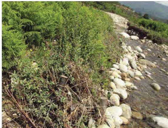
Figura 4. Fajinas de cobertura de ramas brotadas Fuente: Elaboración propia
