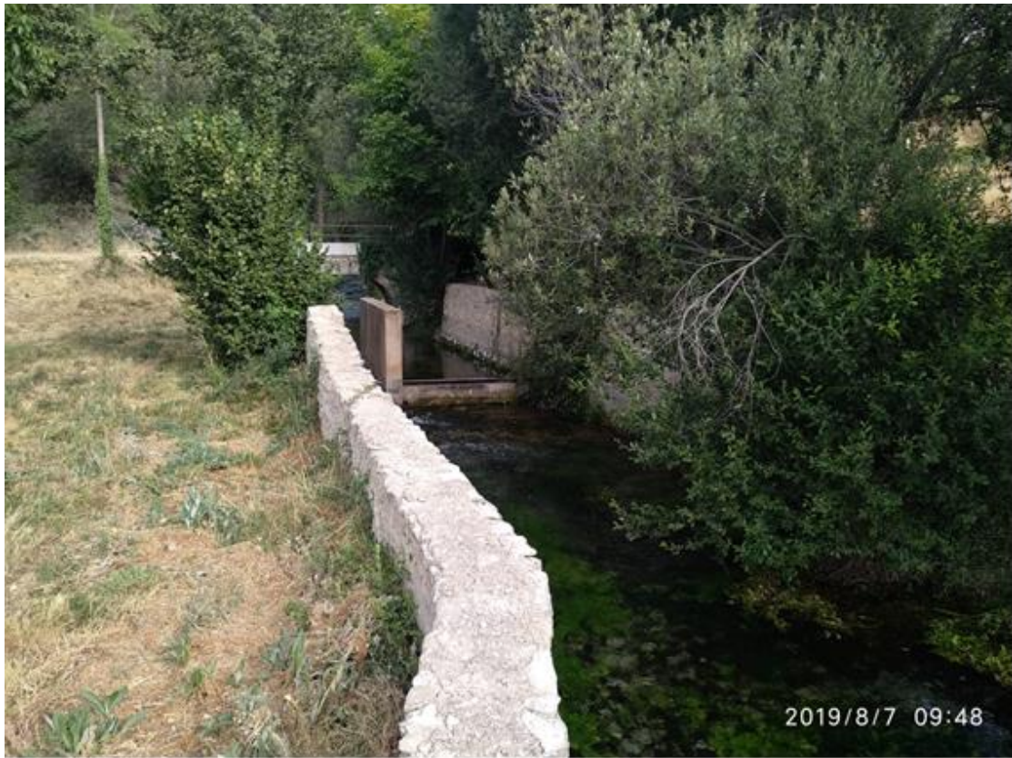
Estación de aforos de La Natividad, punto de medición de la RNS
