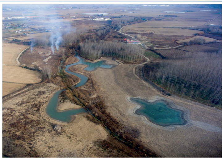
Llanura de inundación con humedales y canal trezado.
