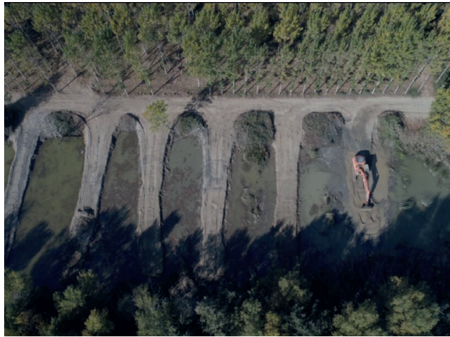
Retirada de fangos en el antiguo meandro.
