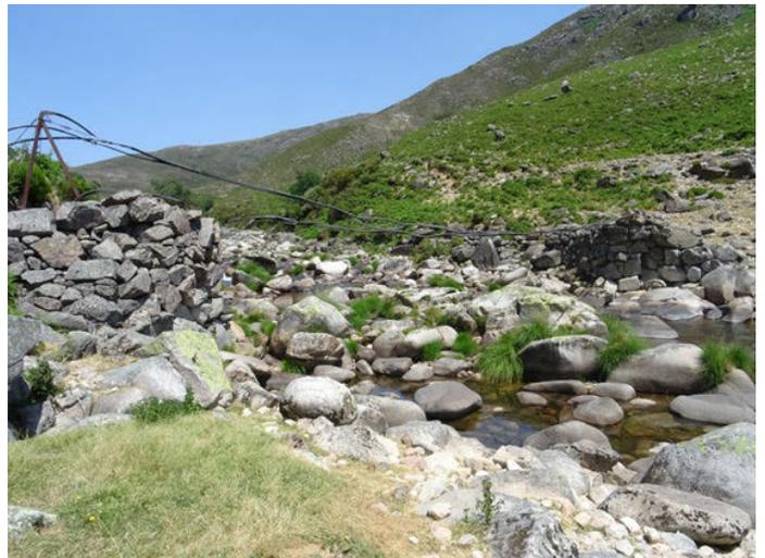
Foto 4. Cruce de tuberías de polietileno sobre el cauce del río Laboreiro en el entorno de Ribeiro de Baixo.
