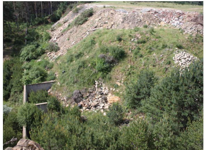
Foto 4: Vertedero en el río Duero
