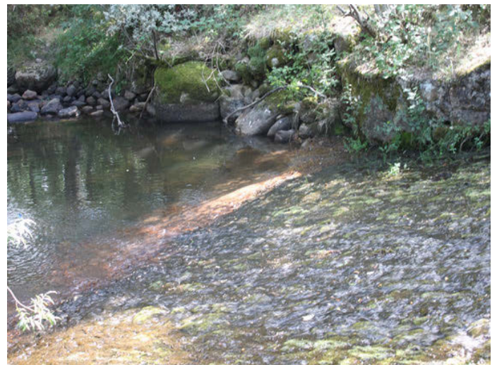
Foto 12. Azud en la parte baja del río Razoncillo
