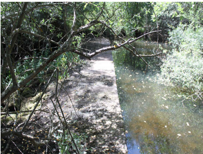
Foto 11. Azud en tramo 3 del río Razón.
