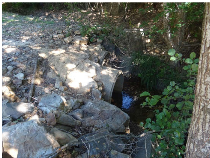
Foto 4: Tramo alto Río Vallosera. Paso entubado
