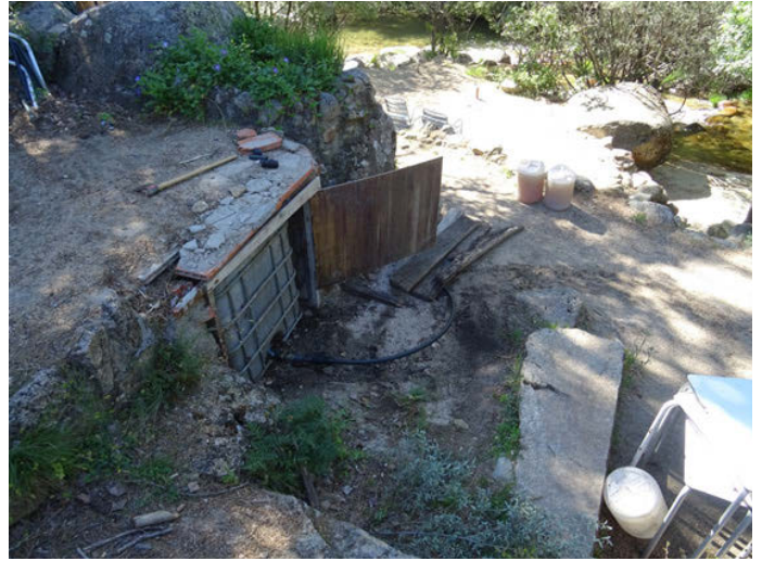
Foto 8. Toma de agua.
