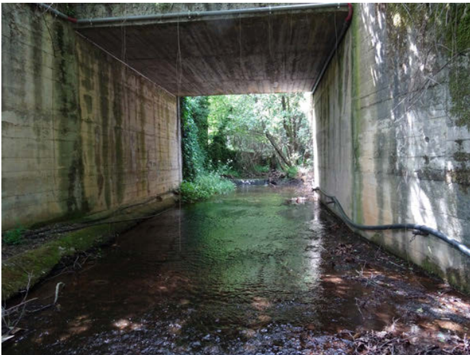
Foto 9: Paso sobre paramento bajo el puente del camino del paraje del Valle del Almonte
