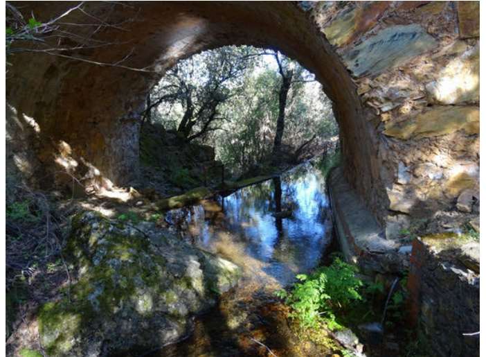
Foto 8: Azud bajo el puente de la carretera CC-97
