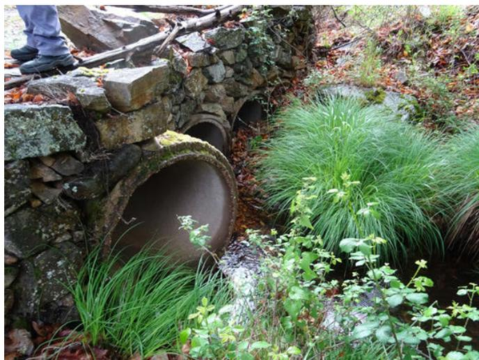
Foto 6. Paso entubado de 3 tubos para el paso de la pista forestal
