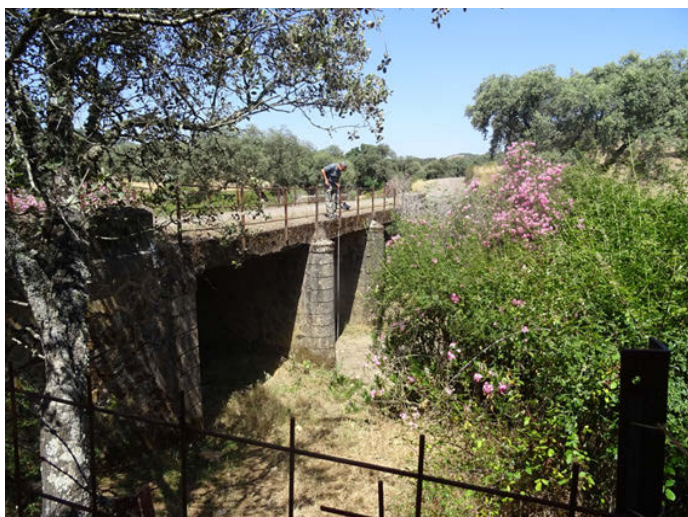
Foto 20: Puente de la carretera HU-917 sobre el arroyo Borbollueto.
