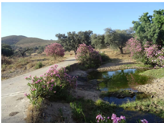
Foto 21: Vado entubado en el tramo bajo de la Rivera de Huelva, antes de la confluencia con el arroyo de la Fuente del Castaño
