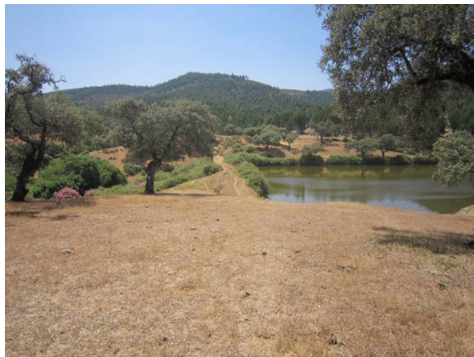
Foto 17: Balsa con dique de tierra, en cabecera del arroyo Borbollueto.
