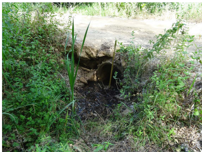
Foto 6: Detalle del vado de la foto anterior, en el tramo alto del Barranco Dundún.
