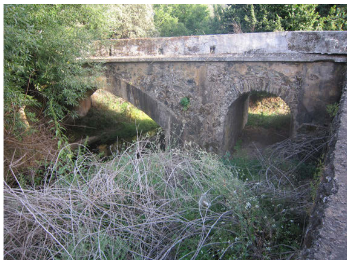
Foto 36: Puente de la carretera a Corterrangel, sobre el arroyo de la Fuente Castaño.
