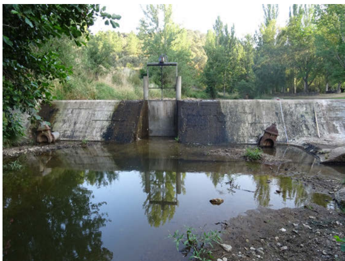
Foto 14: Presa con rebosadero, compuerta y dos tubos para salida de fondo (área recreativa)
