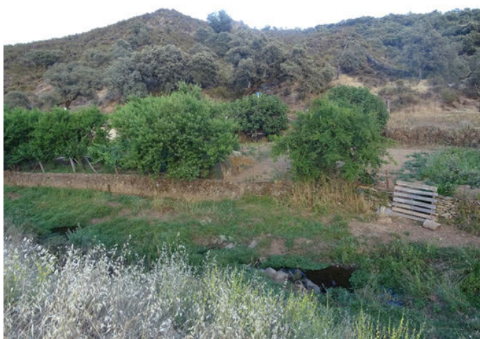
Fotos 37: Arroyo de la Fuente Castaño, vista de muro de protección de huerta y frutales
