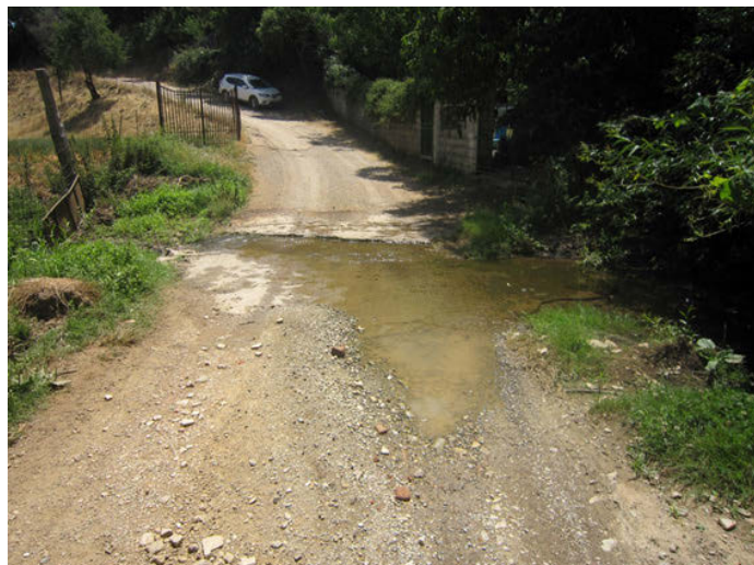
Foto 23: Vado en el arroyo de Fuente del Castaño: obsérvese estructura metálica a la izquierda
