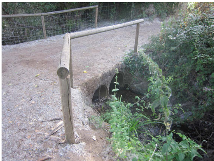
Foto 1: Paso entubado en el Barranco del Pueblo (tramo alto de la Rivera de Huelva)
