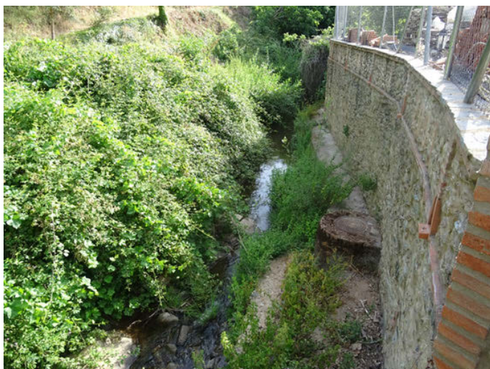
Foto 33: Muro de protección y alcantarilla, en margen del arroyo de la Fuente del Castaño, a su paso por Castañuelos
