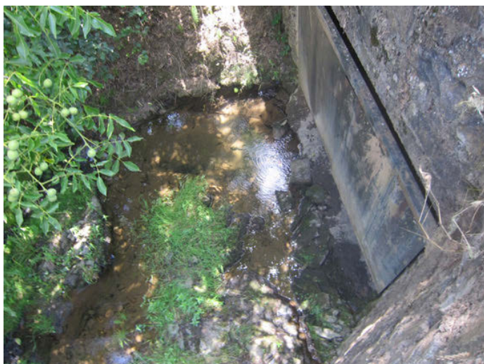
Foto 27: Detalle del puente de la foto anterior, mostrando base cementada.
