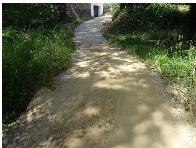
Foto 5: Otro vado situado aguas abajo del anterior, en el tramo alto del Barranco Dundún.
