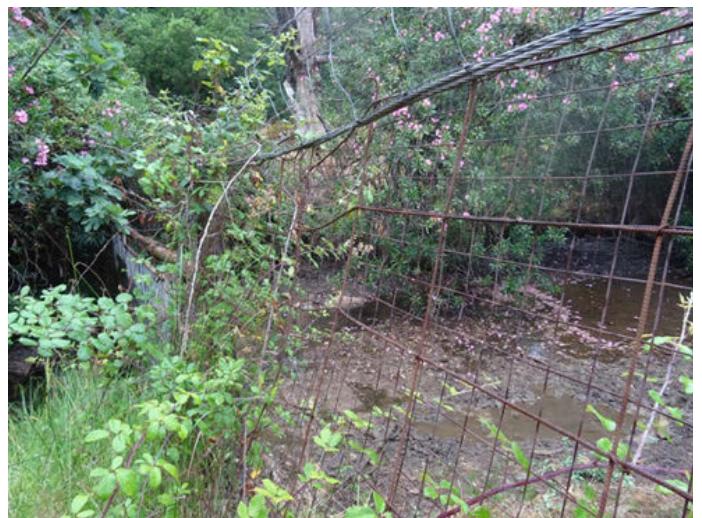
Foto 6: Vista de la retención de agua y sedimentos aguas arriba del cerramiento de la foto anterior
