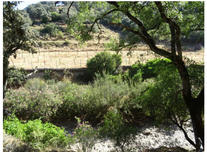
Foto 16: Muro longitudinal junto al cauce.
