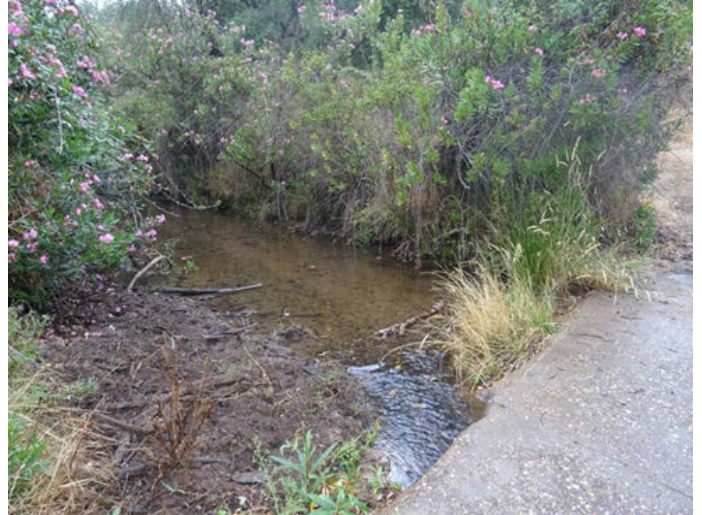
Foto 8: Otro vado en el Aº del Tinte, con paso franqueable pero infradimensionado para el cauce del río, ocasionando alteraciones morfológicas
