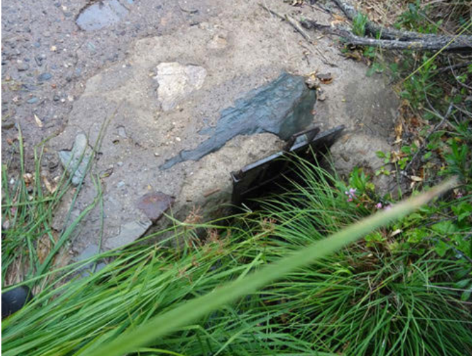
Foto 7: Vado con tubo protegido con rejas en el Aº del Tinte.
