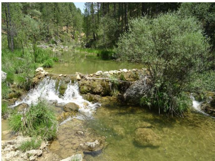
Foto 30. Azud de escollera en el Molino del Prado de la Presa en el río Madera (ES070RNF101\_OBS\_12).
