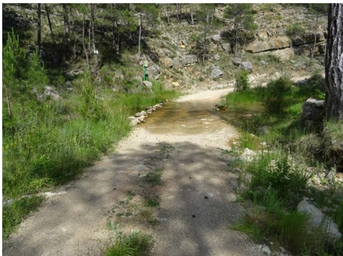
Foto 26. Vado de hormigón para cruce de camino en el río Madera (ES-070RNF101\_OBS\_07).
