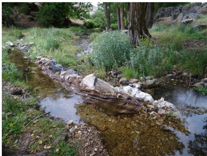
Foto 12. Foto 13. Obstáculo de piedras y plásticos para desviar el agua para uso ganadero en Cortijo de Abajo de Fuente Segura (ES070RNF101\_OBS\_02).
