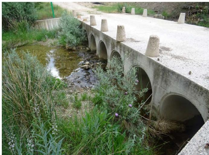
Foto 27. Paso entubado de 8 tubos en el arroyo de las Tres Aguas (que vierte al río Madera) (ES070RNF101\_OBS\_06).
