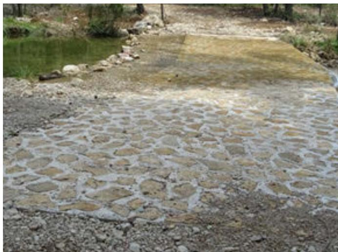
Foto 31. Vado de hormigón con revestimiento de mampostería aguas arriba del camping de Garrotegordo (ES070RNF101\_OBS\_08).
