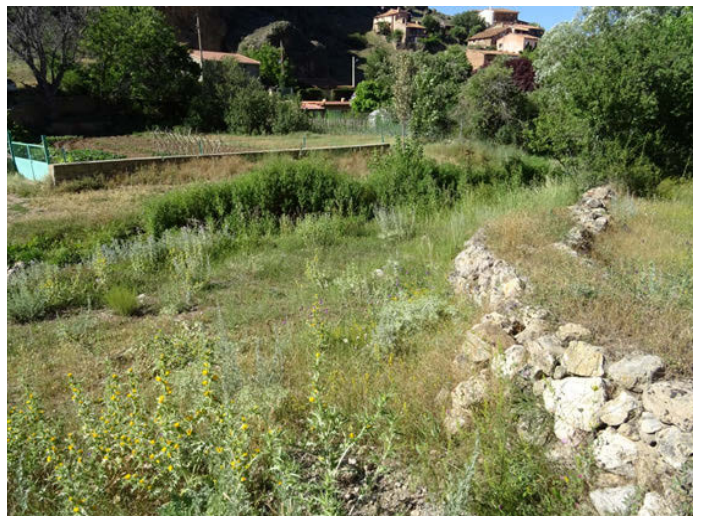
Foto 12. Obstáculos longitudinales en ambas márgenes de la ribera en la vega del Noguera
