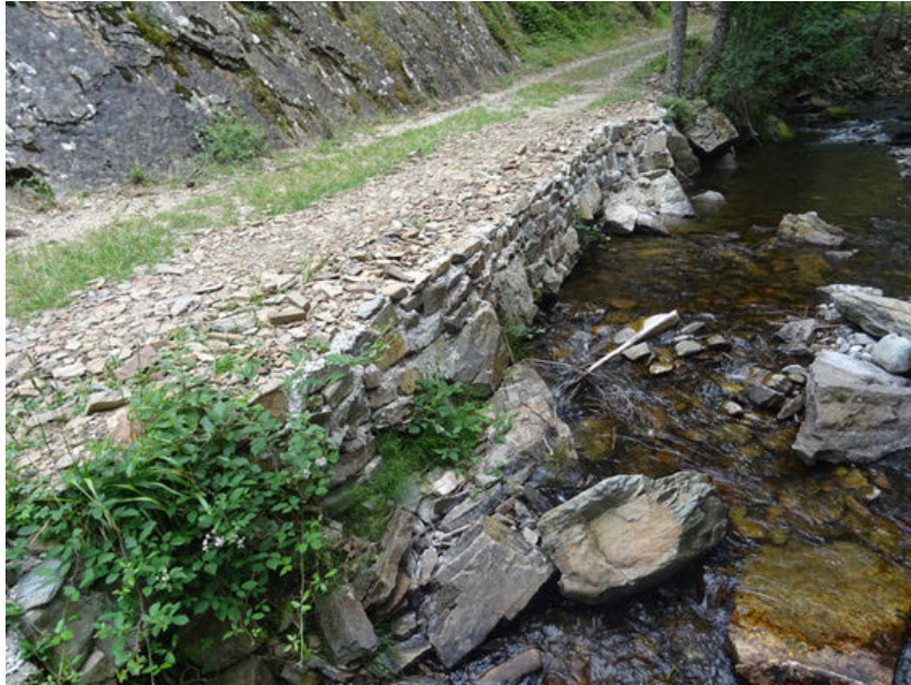
Foto 6: Muro de protección de la pista que discurre junto al río Calamantio.
