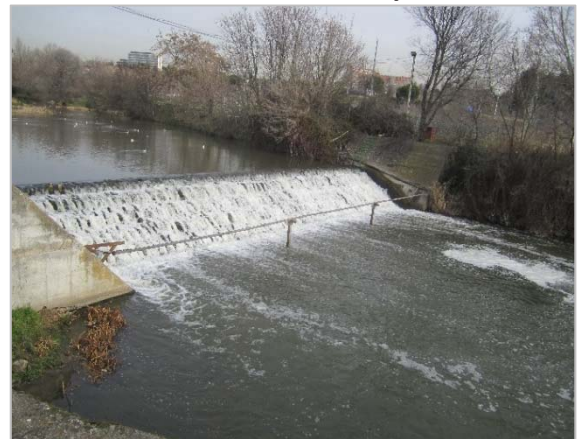
Paso sobre paramento en río Manzanares
