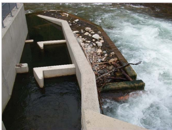
Escalas de estanques sucesivos con problemas en su conservación y funcionalidad: (I) escala colmatada de sedimentos y (II) escala con problemas en la accesibilidad: transición del río al primer estanque.
