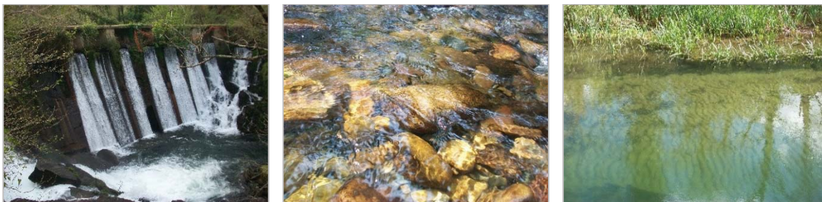
Presa colmatada de Sestelo en el río Suarón. Sedimentos del lecho aguas abajo (canto rodado) y aguas arriba de la presa (arenas).
