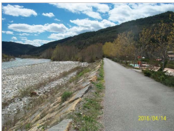
Obras de protección frente a inundaciones: mota escollera y mota de tierras.
