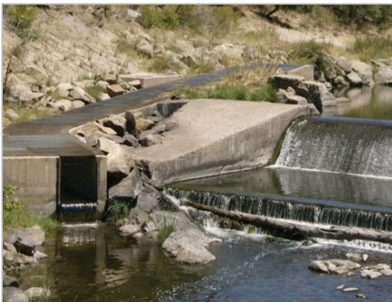
Detalle del acceso a la escala de peces a pie de azud. Salto de 0,55 m desde la poza de remonte a la escala
