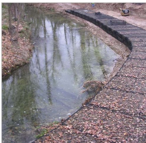
Obras de protección frente a inundaciones: mota escollera y mota de tierras.
