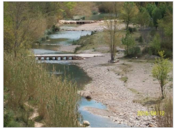
Paso entubado en río Mijares
