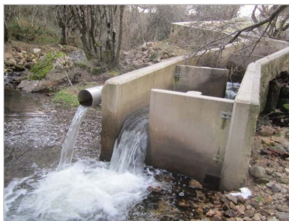
Escalas de estanques sucesivos con problemas en su conservación y funcionalidad: (I) escala colmatada de sedimentos y (II) escala con problemas en la accesibilidad: transición del río al primer estanque.
