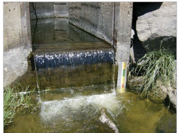
Detalle del acceso a la escala de peces a pie de azud. Salto de 0,55 m desde la poza de remonte a la escala
