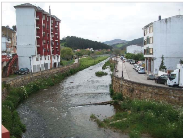
Actuaciones para fijar el lecho: diques de fondo y enlosado.
