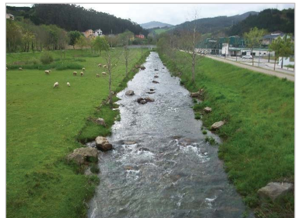
Actuaciones para fijar el lecho: diques de fondo y enlosado.
