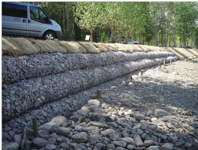
Obras de protección de taludes: gaviones.
