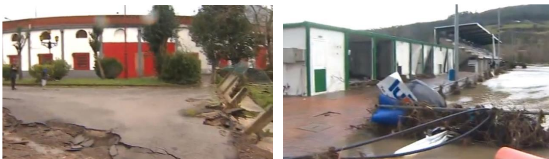
Fig. 09: Daños en Ampuero: plaza de toros e instalaciones deportivas. RTVE 02/02/2015.
