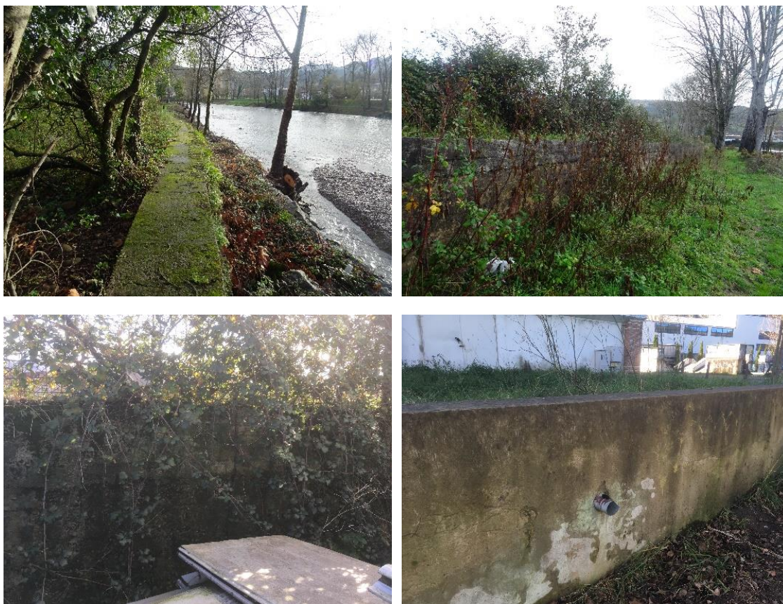
Fig. 27: Muro de contención en el margen izquierdo del río Asón a su paso por Ampuero.
