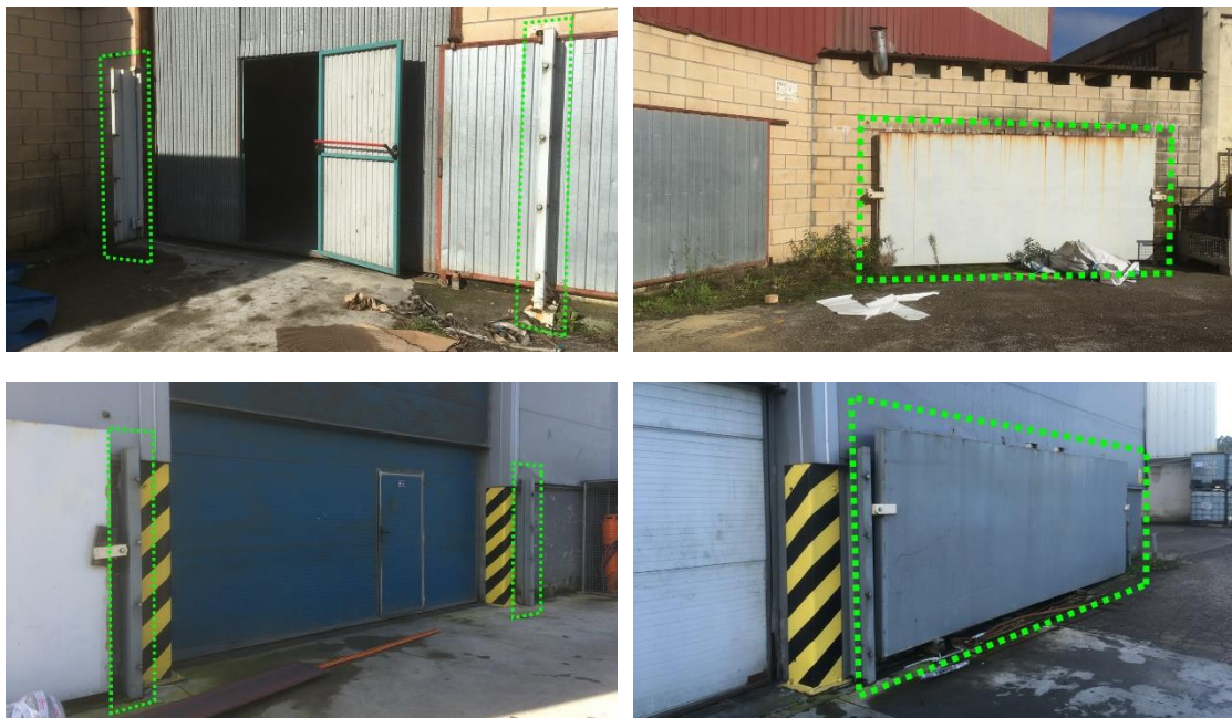
Fig. 36. Medidas de autoprotección en Teknia: portones metálicos desmontables y guías para su instalación.
