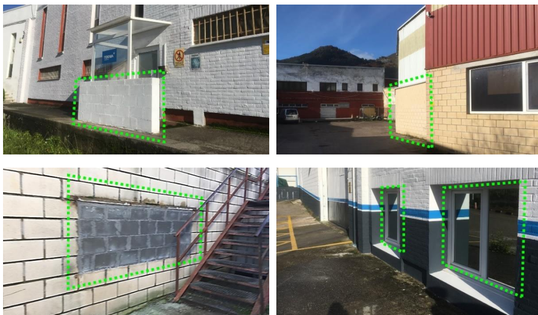
Fig. 45. Otras medidas en Teknia: muretes de protección, antepechos, sellado de huecos y cristales blindados.
