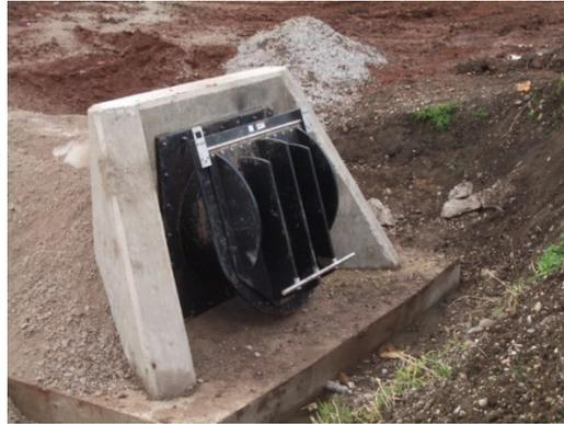
Ilustración 34. Válvula antirretorno de clapetas.
