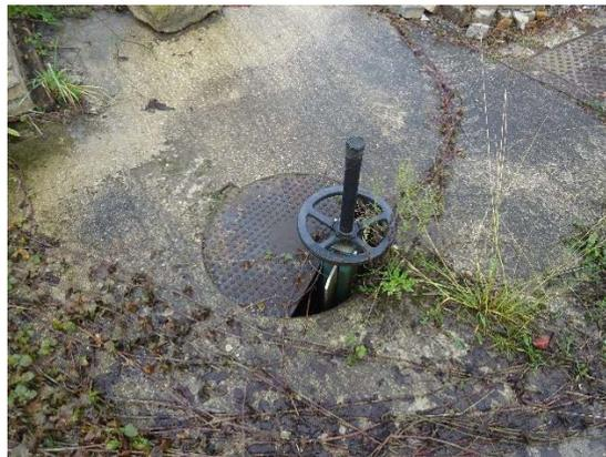
*Ilustración 36 Válvula de retención en arqueta.*
