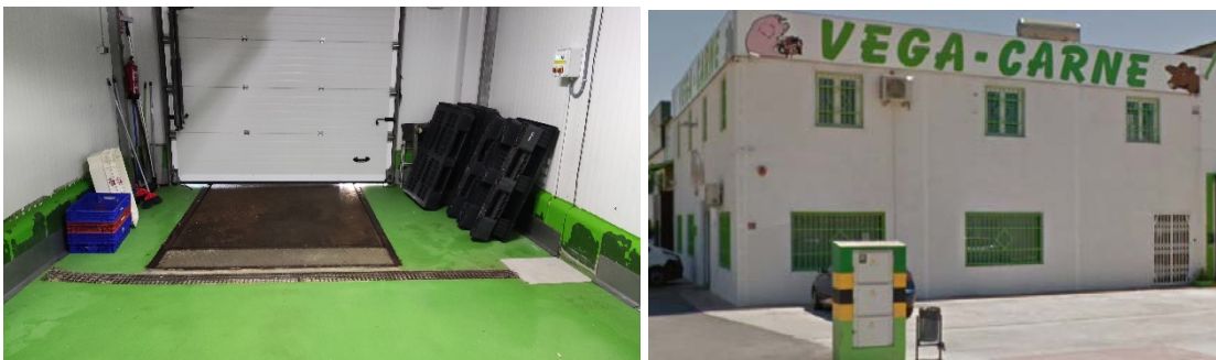
Ilustración 28. Portones interiores y ventanas laterales
