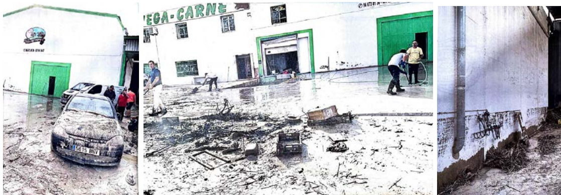
Ilustración 5. Daños en el exterior de las instalaciones por la DANA de 2019
