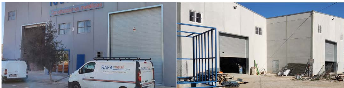
Ilustración 17. Accesos de la nave más moderna. Acceso de camiones y entrada principal.
