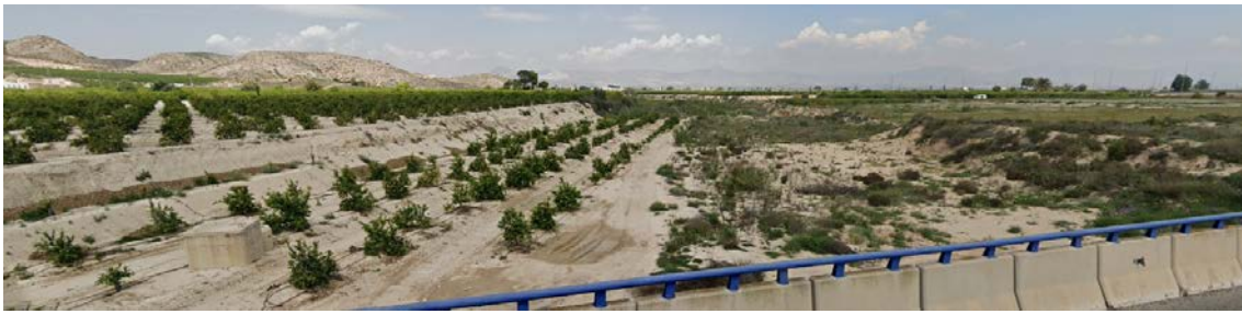
Ilustración 7. Rambla de Abanilla aguas arriba de la A-7.
