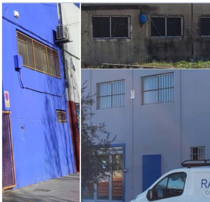
Ilustración 18. Detalle de las diferentes ventanas de ambas naves.
