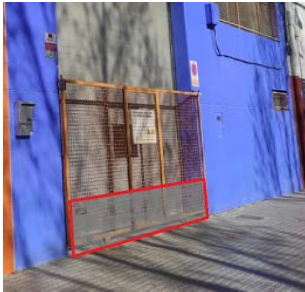
Ilustración 28. Ubicación de la barrera temporal de paneles de aluminio en puerta peatonal Calle F. García Lorca.
