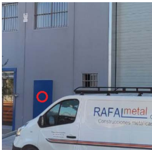
Ilustración 25. Ubicación de la barrera temporal Floodgate en puertas peatonales en calle de la Hispanidad.
