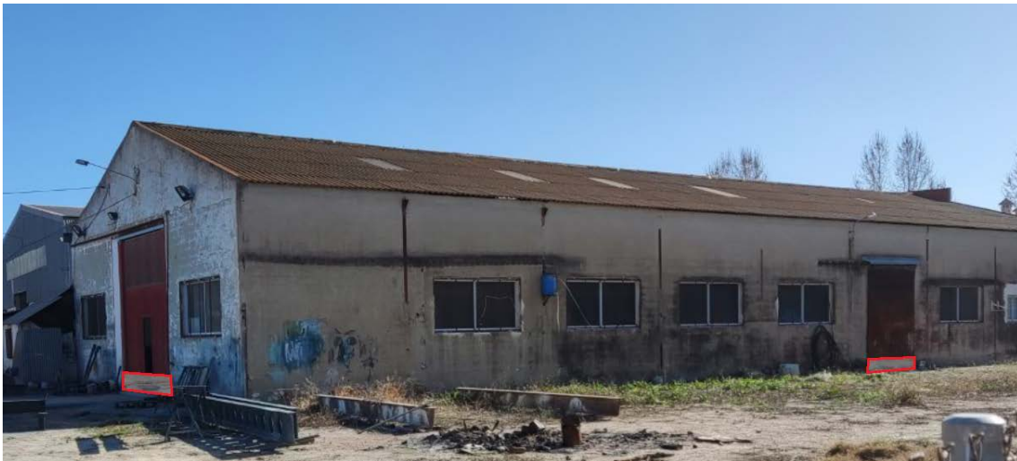
Ilustración 29. Ubicación de la barrera temporal de paneles de aluminio en lateral y portón trasero de la nave de almacén.
