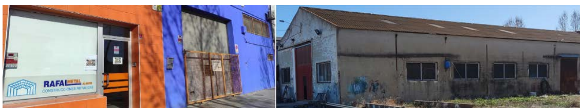
Ilustración 16. Accesos de la nave más antigua. Acceso de camiones y entrada principal
