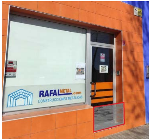
Ilustración 24. Ubicación de la barrera temporal Floodgate en puerta peatonal en calle F. García Lorca.
