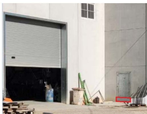
Ilustración 26. Ubicación de la barrera temporal Floodgate en puerta peatonal trasera de nave de producción.
