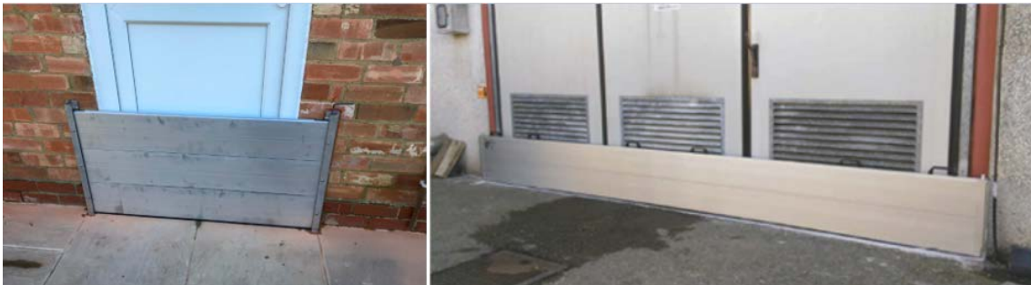
Ilustración 27. Barreras temporales de paneles de aluminio.
