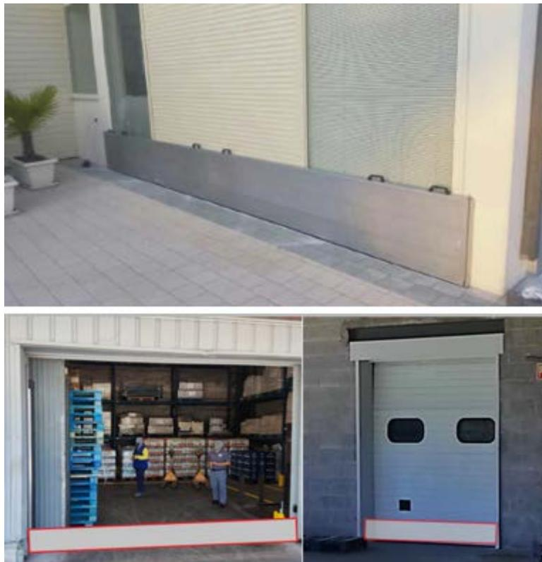
Ilustración 47. Paneles de aluminio en puertas del muelle de carga.
