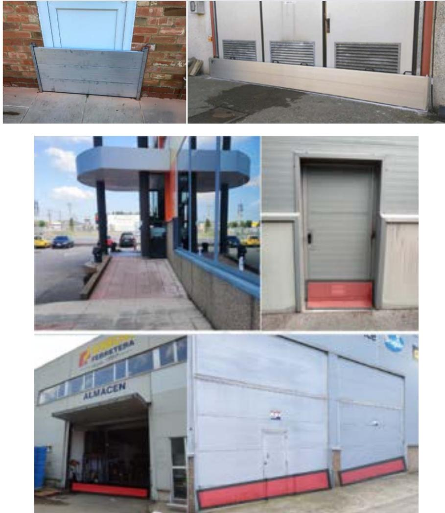
*Ilustración 32. Barrera temporal de paneles de aluminio en puertas y portones.*
