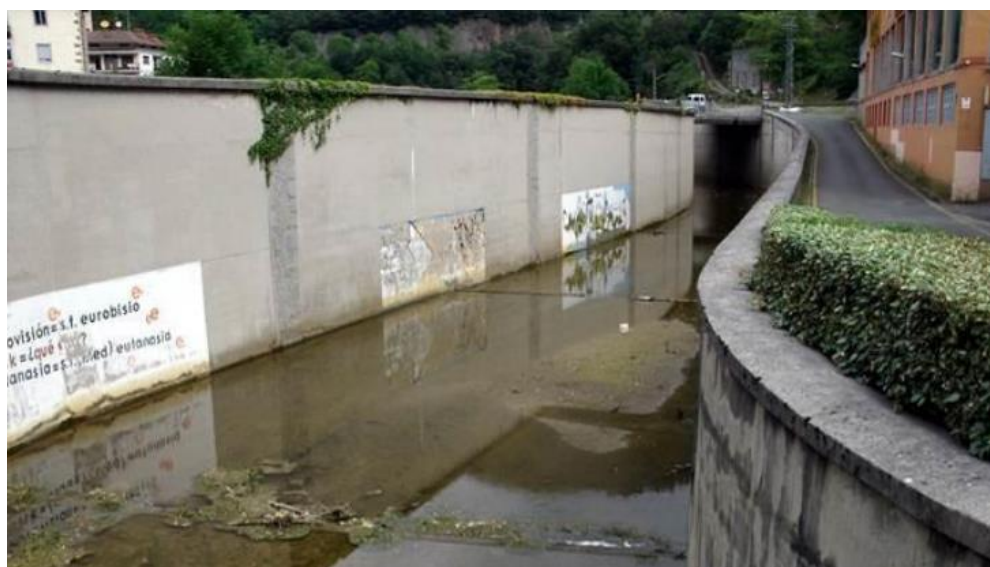
Canalización del río Kilimoi en la zona de confluencia con el río Deba
