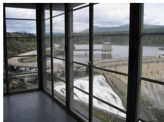
Ilustración 9: Presa de El Villar. Río Lozoya (Madrid).
