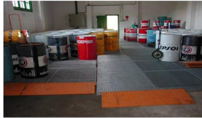
Recogida de posibles fugas en bidones almacenados
