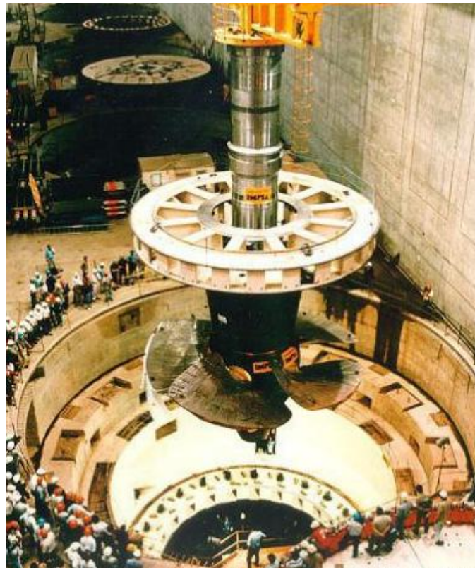
Ilustración 6: Turbina Kaplan.
