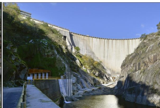
Ilustración 16: Minicentral en la presa de Belesar. Río Miño (Lugo).
