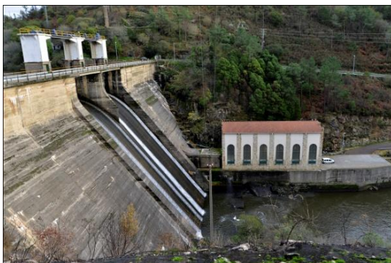
Ilustración 15: Minicentral Tambre III. Río Tambre (La Coruña).
