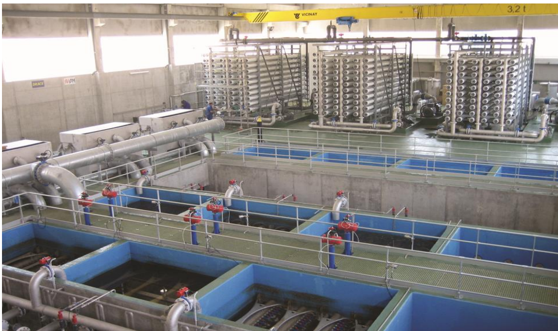
Ilustración 2: Regeneración de agua mediante filtración, ósmosis inversa y desinfección por rayos UV.
