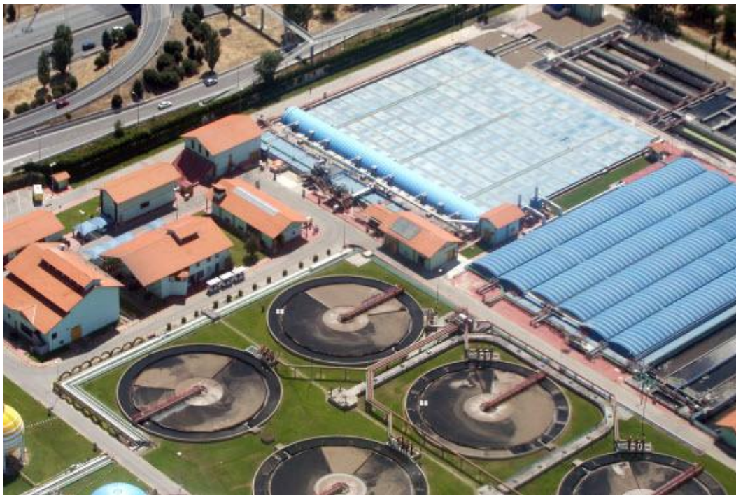
Ilustración 1: Planta regeneradora de agua dentro de la EDAR de Viveros de la Villa (Madrid) con una producción de 1.332.233 m 3 /año de agua regenerada para riego de parques y zonas verdes.
