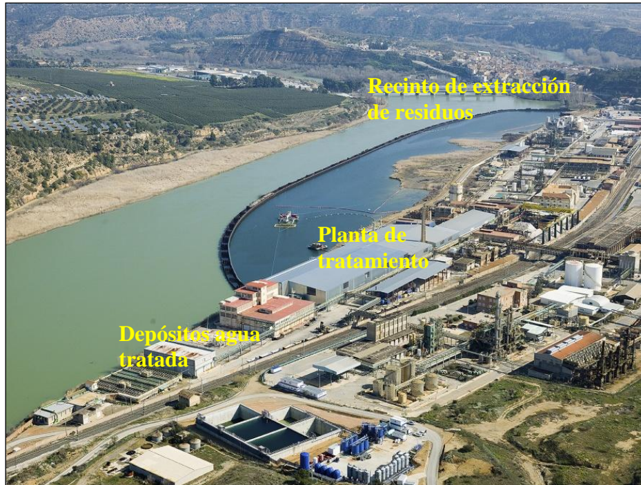
Ilustración 5. Proceso de descontaminación del embalse de Flix.
