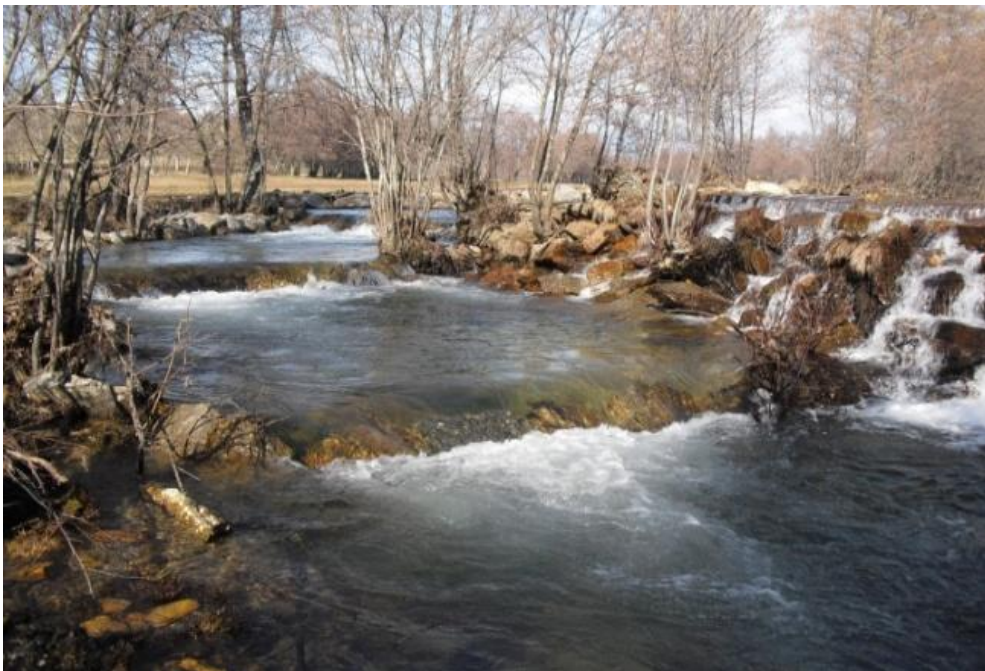
Ilustración 4. Escala para peces construida en el río Negro (Zamora).
