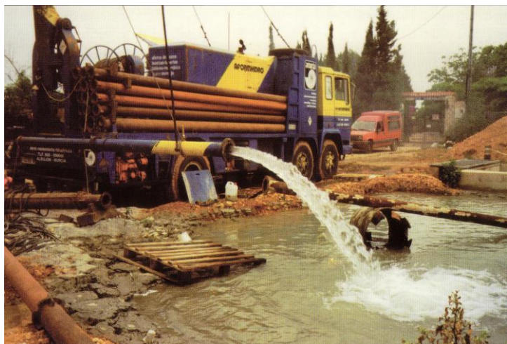
Ilustración 2: Máquina de perforación por el sistema de roto percusión y ensayo de bombeo
