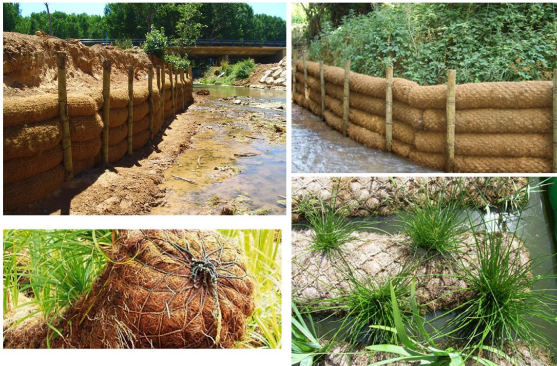
Utilización de biorrollos para la revegetación de riberas.
