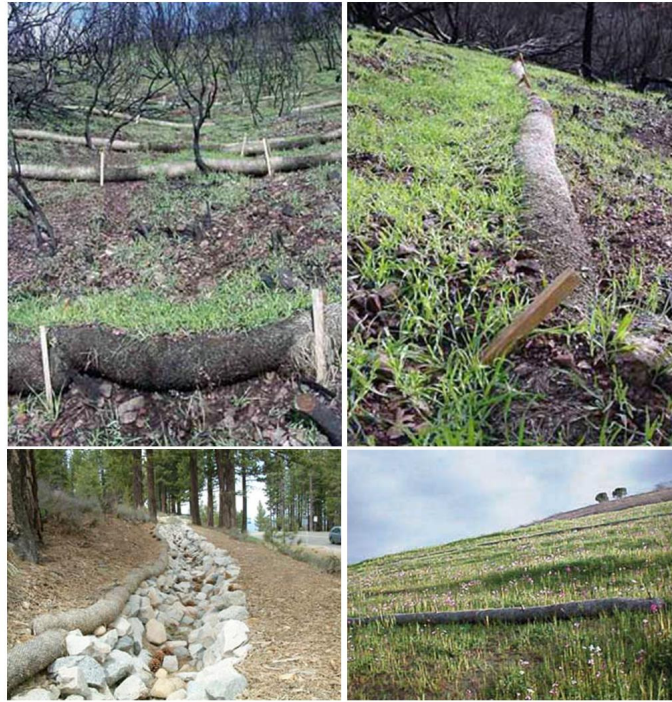
Utilización de biorrollos para estabilizar el suelo tras incendios forestales.
