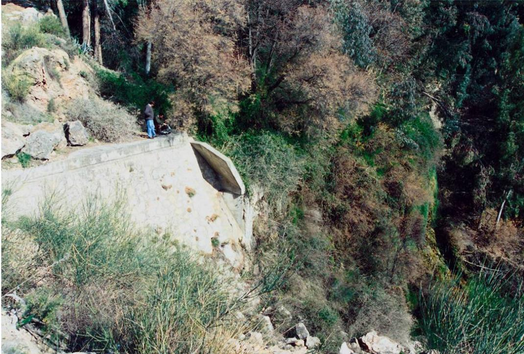
*Dique de contención de deslizamientos de ladera en el Torrente Salado, Lanjarón, Granada. (Fuente: Archivo TRAGSATEC)*
