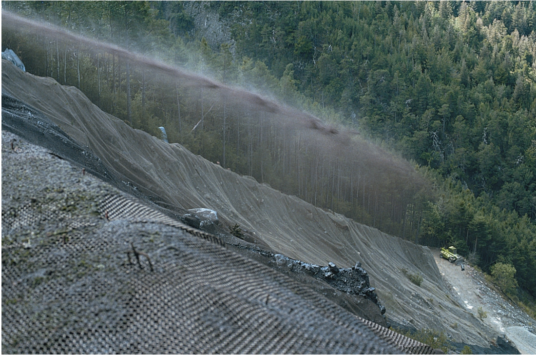
Tratamiento de una concha de erosión mediante mallas de polietileno e hidrosiembra (Fuente: José Nicolás).
