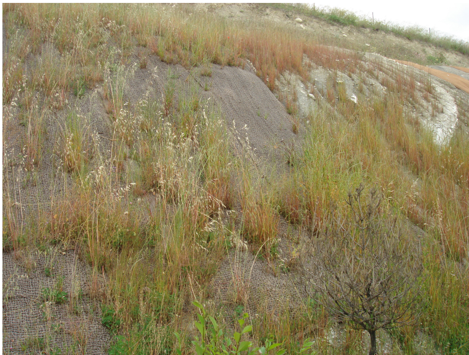
Talud tratado con mantas orgánicas hidrosembradas.
