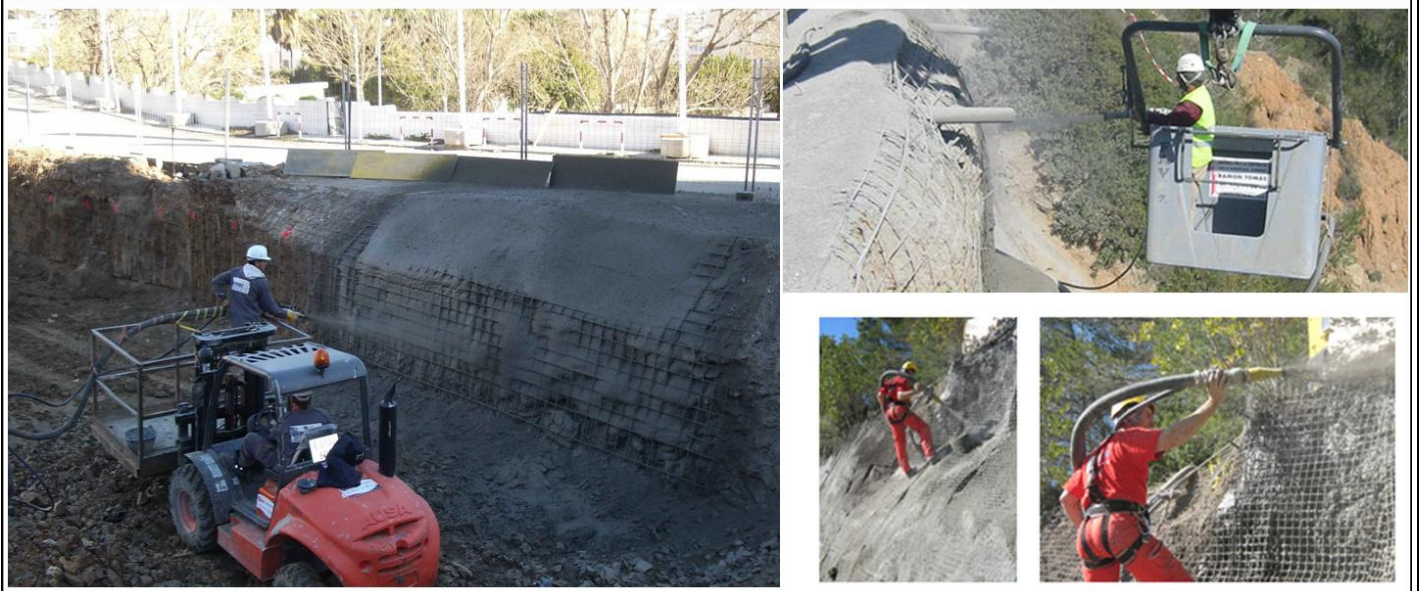
Aplicación de gunitado para la protección de taludes.
