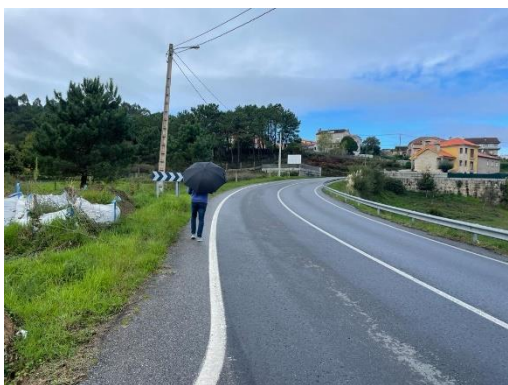
Estado actual (previo a la ejecución de la actuación)
