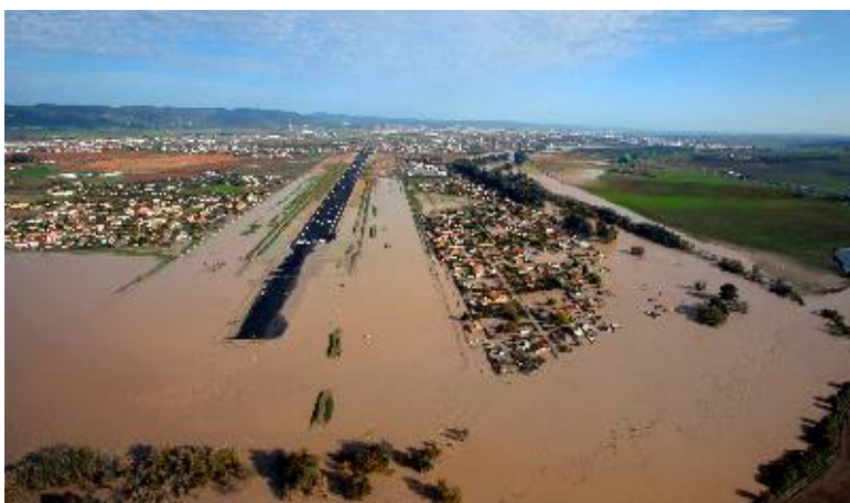
Parcelaciones junto a la pista del aeropuerto de Córdoba, inundadas por la crecida del río Guadalquivir debido a las fuertes lluvias.
