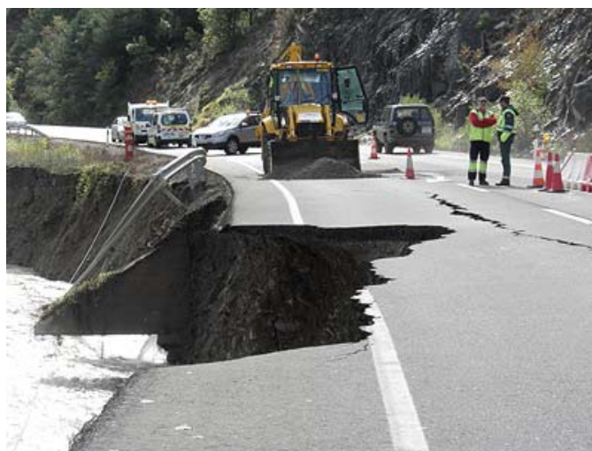
Socavón en la carretera N-330, cerca de la localidad oscense de Castiello de Jaca, provocado por la crecida del río Aragón después de lluvias intensas.
