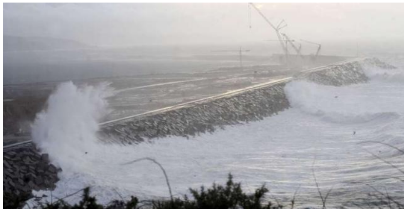
Dique del puerto exterior de A Coruña durante un temporal
