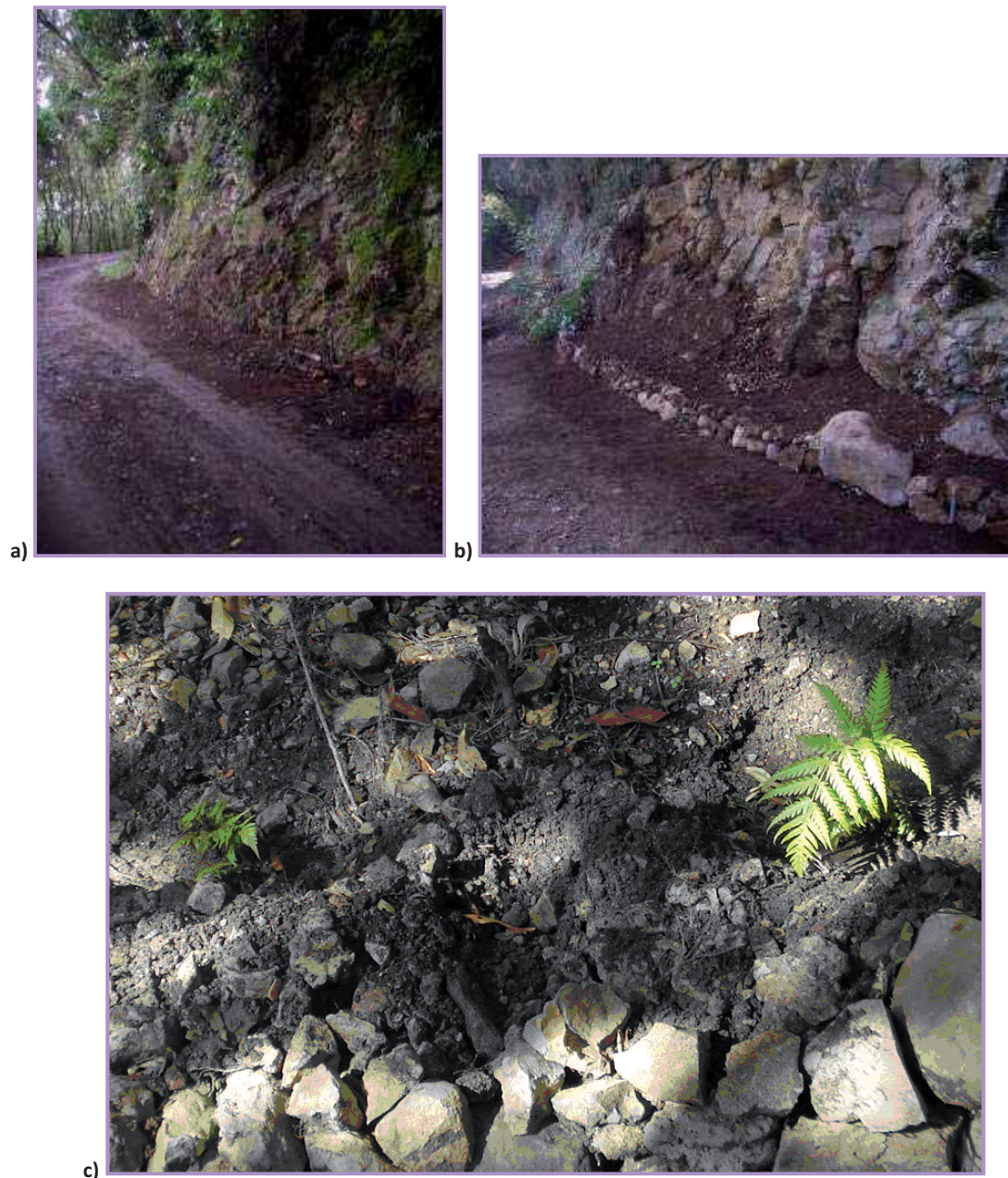
Foto 10. a) Mancha 9_1 de T. fluminensis eliminada. b) Acondicionamiento de la zona de repoblación con Woodwardia radicans . c) Ejemplares de Woodwardia radicans utilizados para la repoblación de la mancha 9_1 del Tramo 9 del Cedro.
