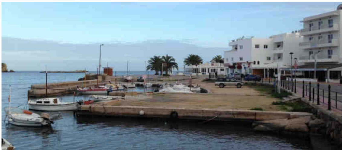
Ilustración 2 Vista general del refugio marítimo a consolidar.
