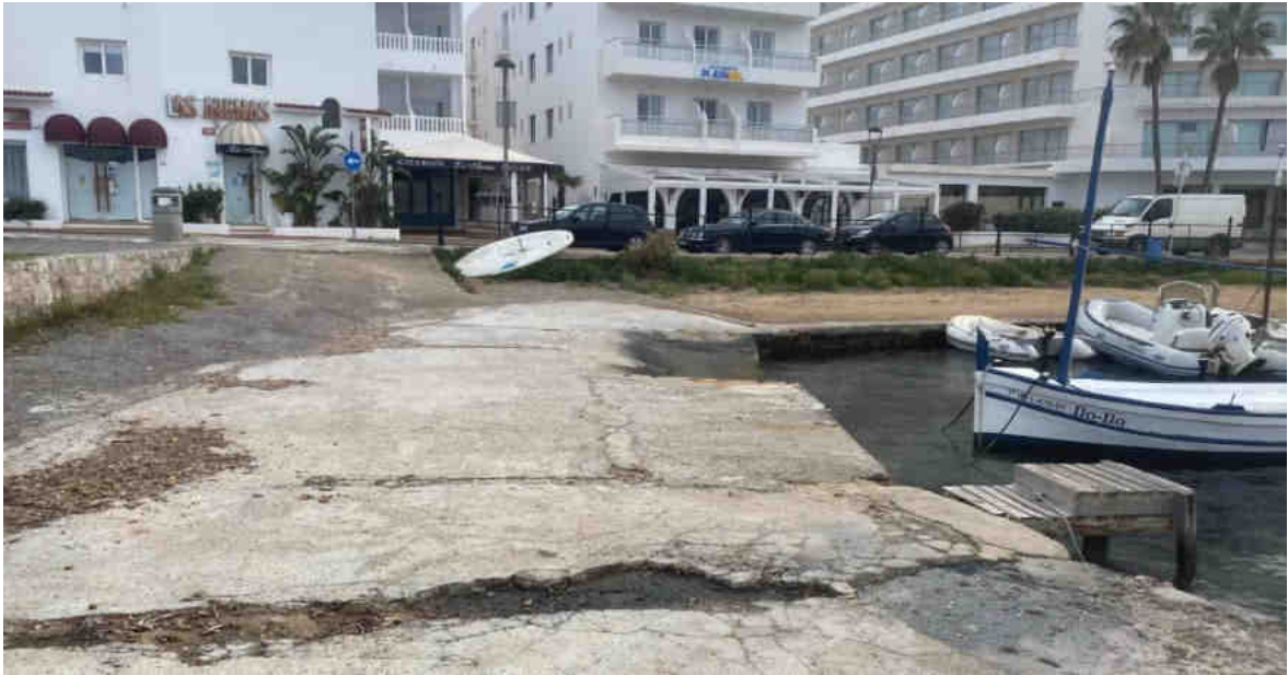
Foto 7. Explanada terrestre del refugio marítimo parcialmente hormigonada. Se observa el acceso rodado a la rampa de varada existente.
