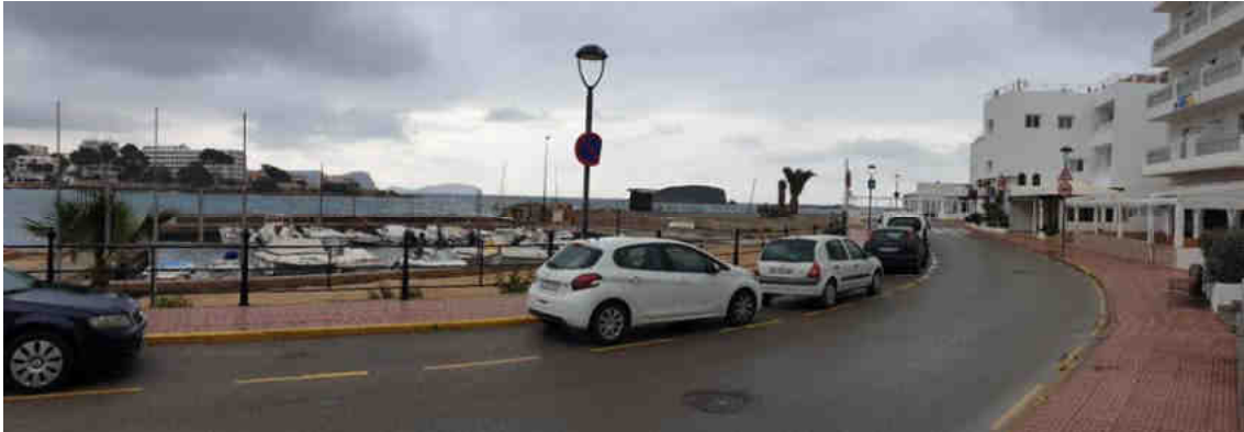
Ilustración 3 Vista de la Avenida des Canar y del refugio marítimo conocido como "Puerto de Es Canar".
