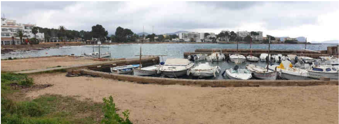
Foto 5. Detalle de la plataforma terrestre de la dársena del refugio marítimo donde actualmente amarran embarcaciones de entre 5 y 6 m de eslora.
