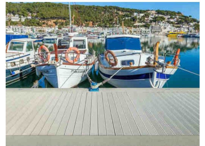
Renovación de los elementos de amarre
