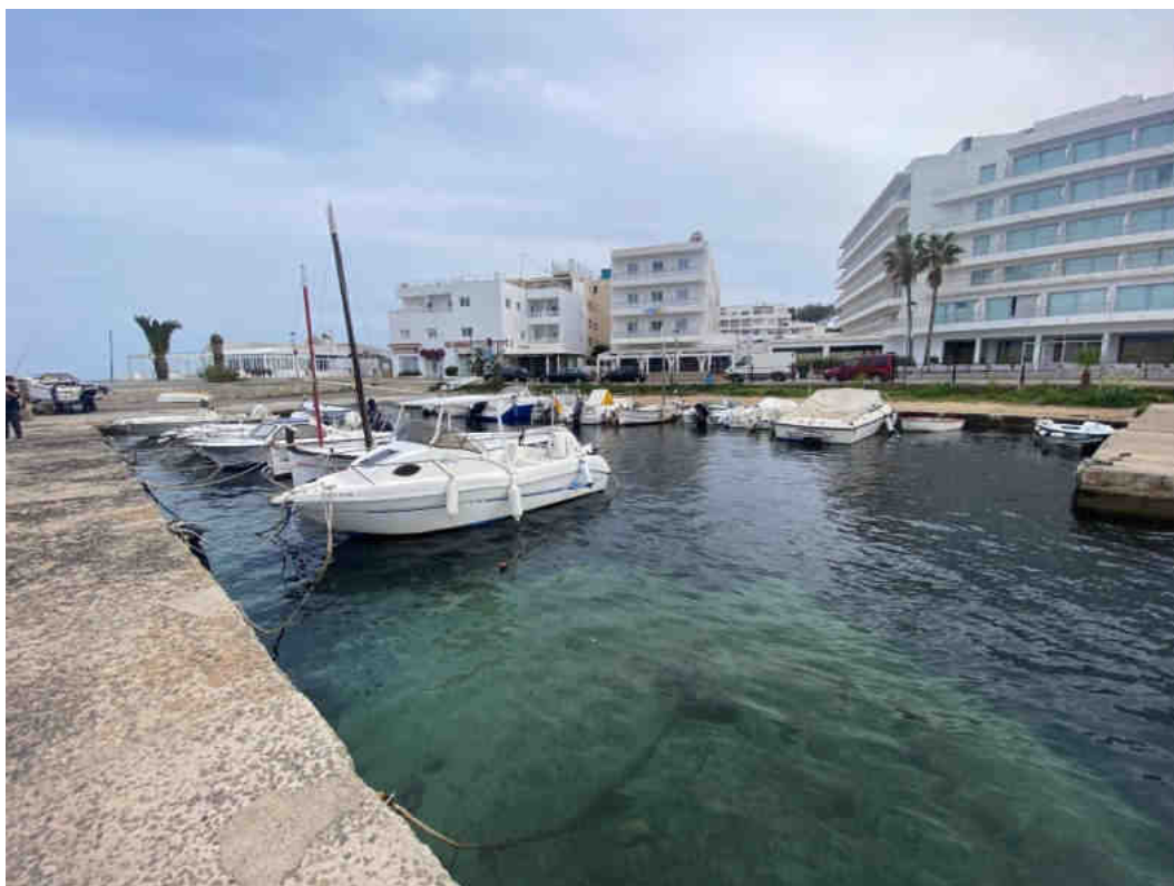
Ilustración 19 Zona de amarre para embarcaciones
