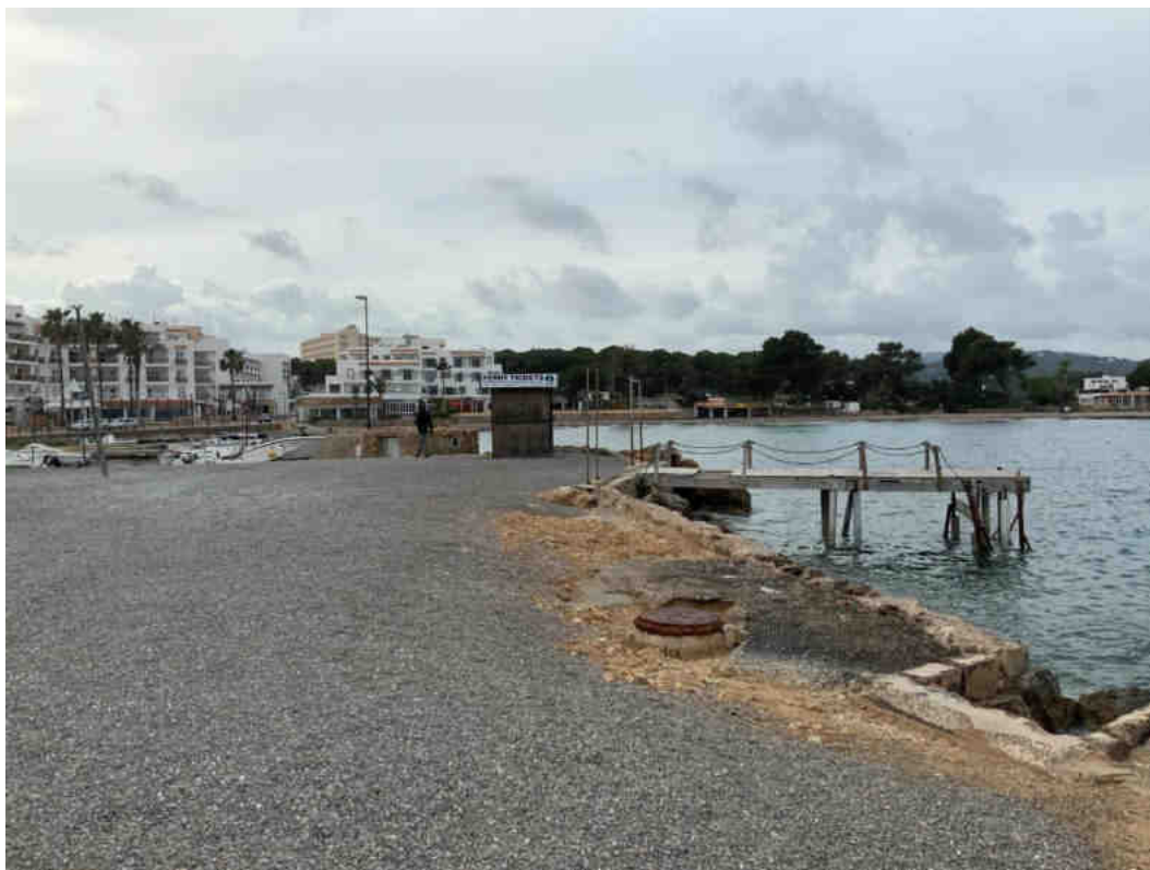
Ilustración 12 Zona de salida al mar del emisario a retirar.
