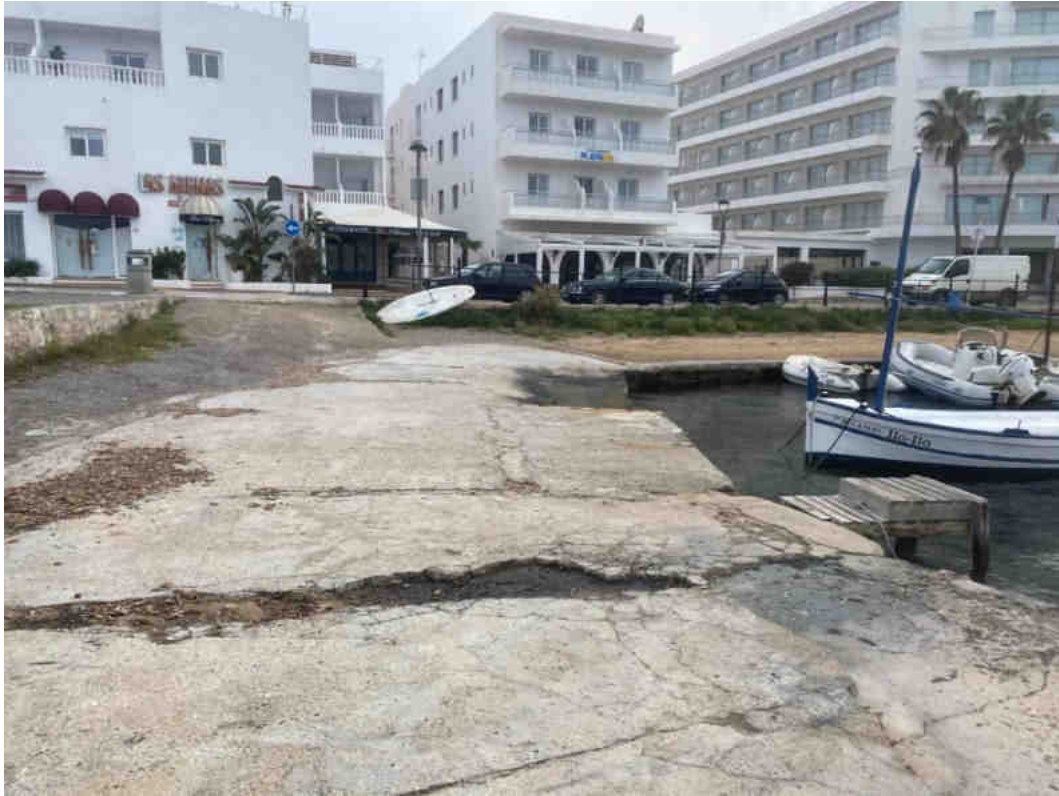
Ilustración 14 Explanada terrestre del refugio marítimo parcialmente hormigonada
