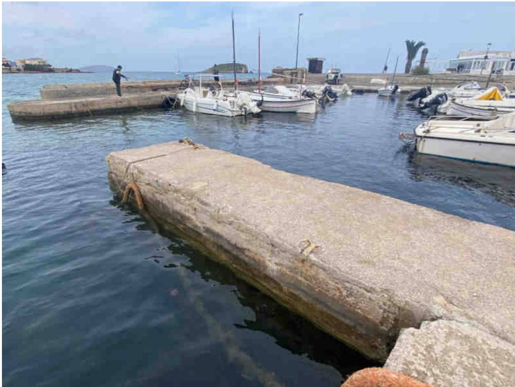
Ilustración 28 Contradique existente en la zona de abrigo marítimo.
