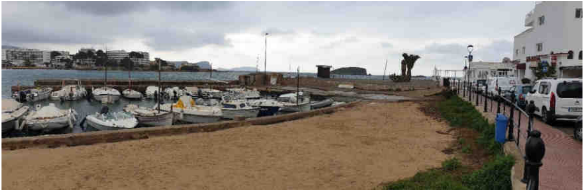
Foto 4. Relleno de tierras en la explanada existente frente al refugio marítimo.
