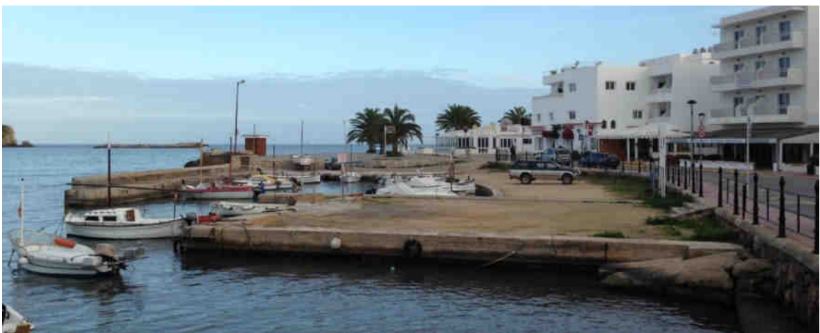
Foto 3. Vista general del refugio marítimo a consolidar desde el extremo sur de la playa de Es Canar, en la fachada marítima de la Avenida de Es Canar.
