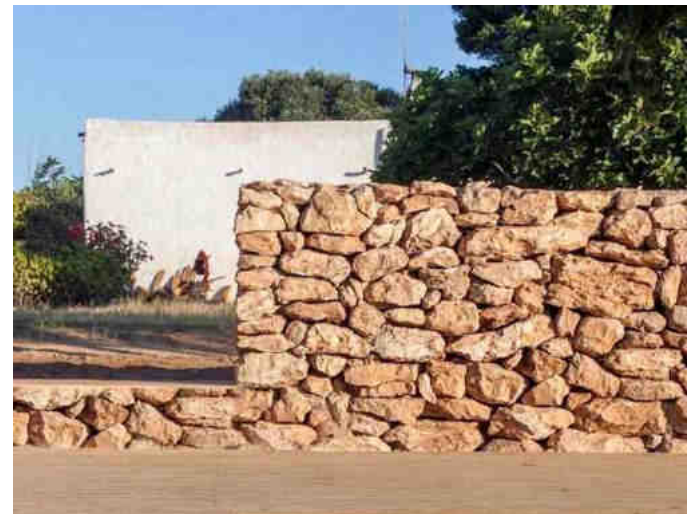
Reconstrucción de muros de piedra seca
