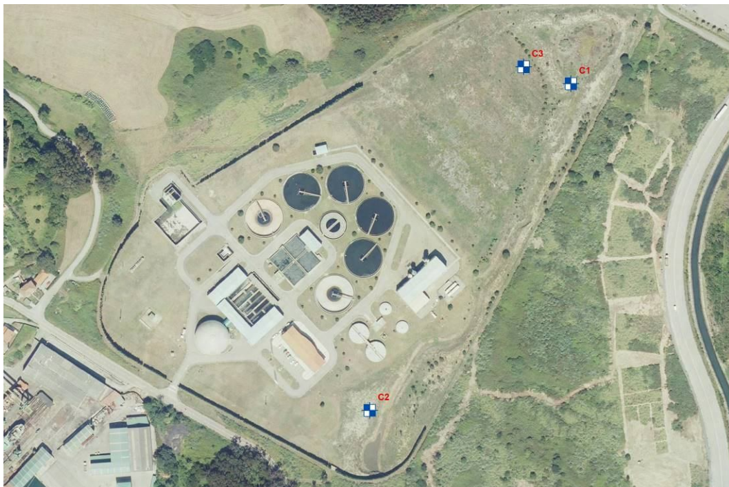
Figura 2.- Vista aérea de la zona estudiada con la situación de las calicatas.
