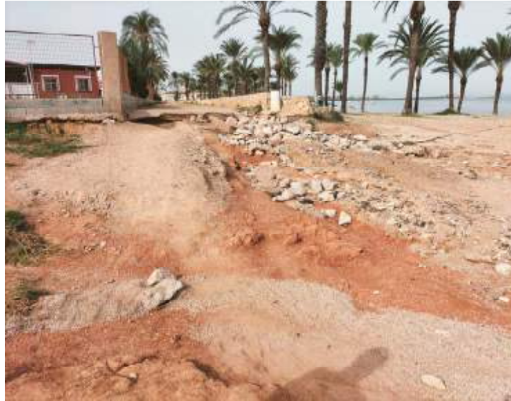
Estado actual del paseo junto al camping Villas Caravanning
