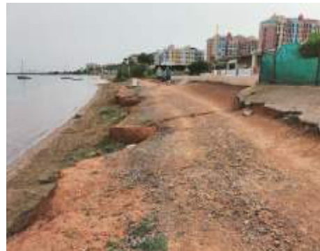
Desniveles y obstáculos en el paseo
