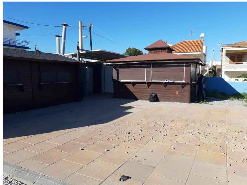
F6- VISTA GENERAL DESDE LA ZONA DE MESAS HACIA LOS MÓDULOS
