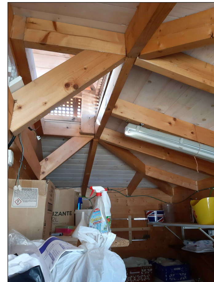
VISTA GENERAL DE LAS CUBIERTAS TIPO DE LOS MÓDULOS
