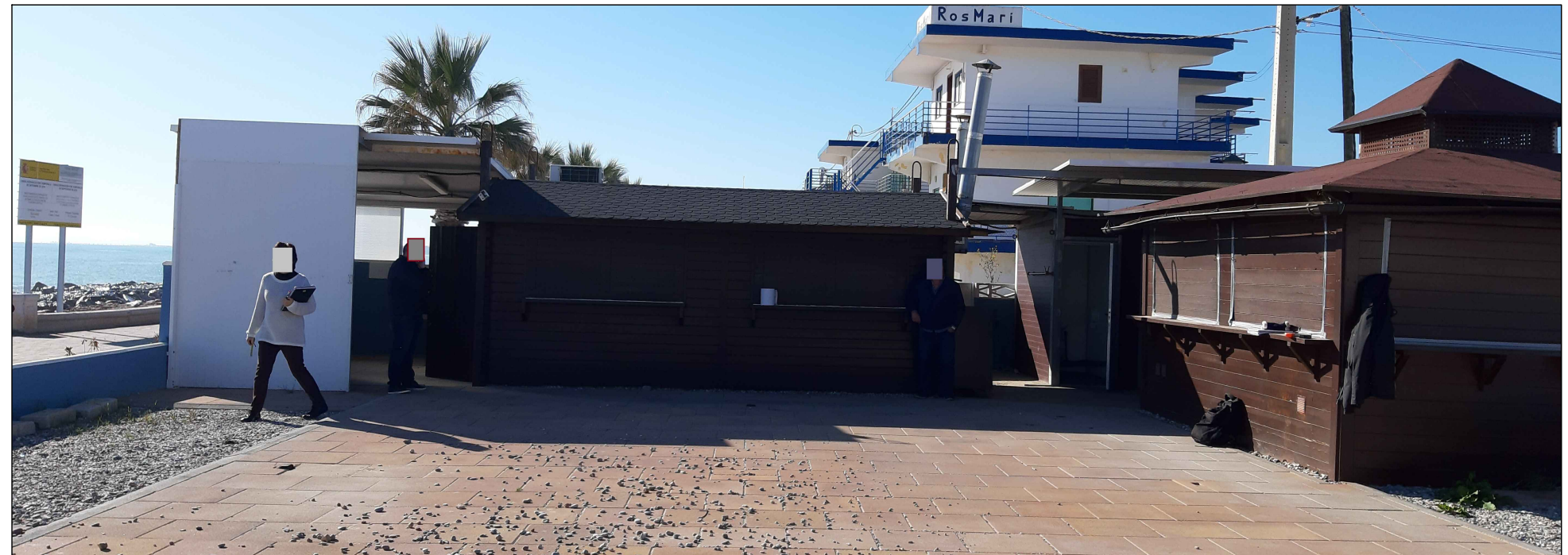
VISTA GENERAL DE LOS DOS MÓDULOS DE COCINA Y BARRAS
