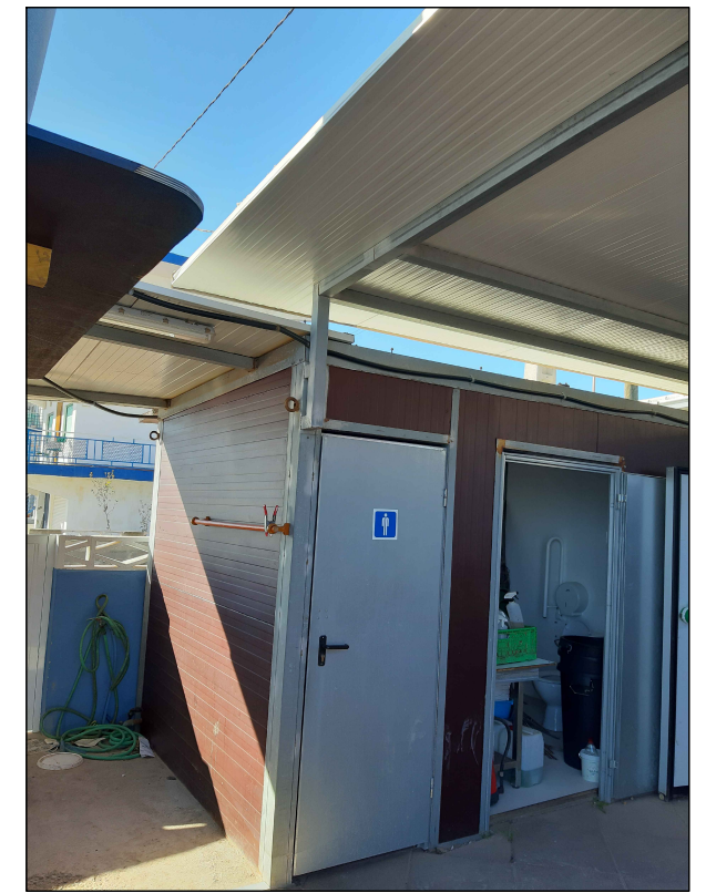
F3-FOTO ASEOS. VÉASE EL PANEL DE CERRAMIENTO TIPO SANDWICH Y LA CUBIERTA
