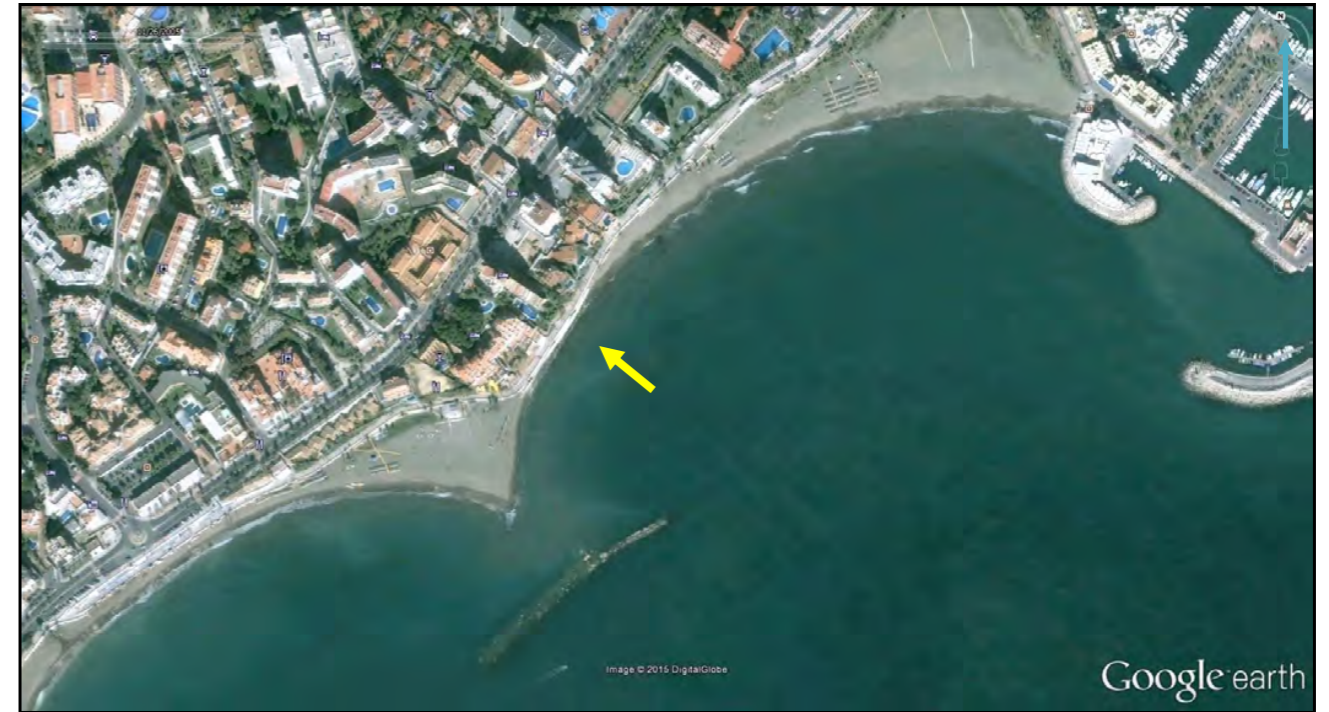
Año 2005. La forma en planta general de la playa de Malapesquera es más o menos estable. El tómbolo inicial ha degenerado en un hemitómbolo muy variable, y se observa claramente la continua zona de erosión.
