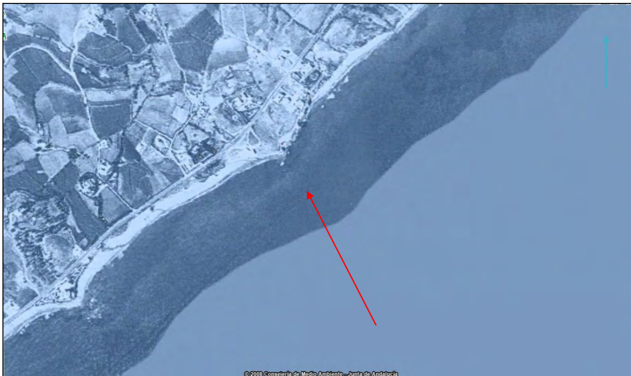
Vuelo Americano, años 1956-57. No existen obras marítimas ni el puerto deportivo. Se señala actual emplazamiento del dique de Malapesquera. Apenas existe presión urbanística, aunque ya está construida la carretera nacional que sirve de eje ordenante de la futura actuación urbanística.
