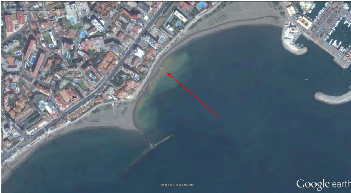
Ejecución de apéndice de escollera para retención parcial de arenas (espigón corto). Abril de 2014.
