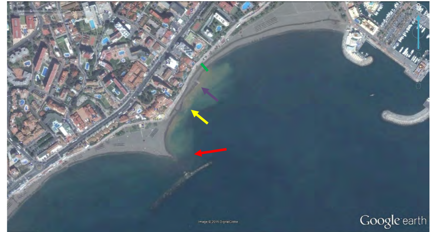
Abril de 2014. Construcción de apéndice de escollera (color morado) para paralizar parcialmente la circulación de arenas hacia zona del puerto deportivo, pero que crea cierta regresión justo a levante de dicho apéndice (comparar ancho en zona señalada en verde con la misma zona en fotografía de Octubre de 2011). Recuperación aun mayor del hemitómbolo, por continuación de temporales no frecuentes de poniente.
