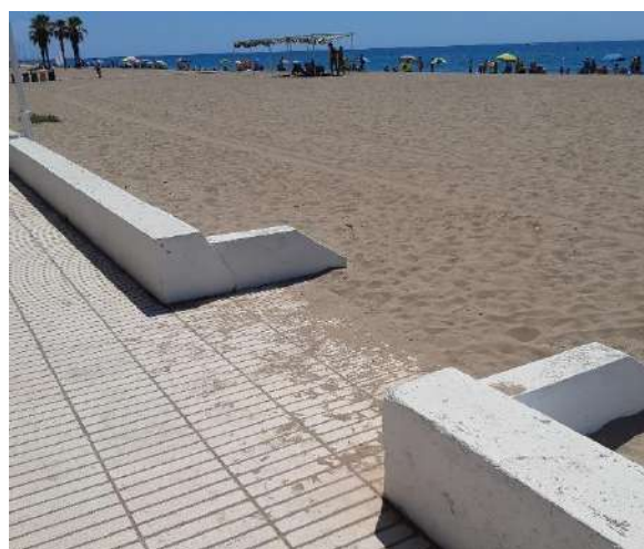
Foto 23. Demolición de acceso
