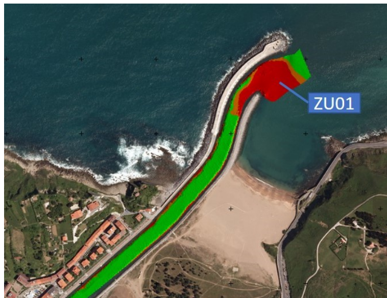
Figura 1. Situación de calados en el puerto de Zumaia en 24 de marzo de 2020. Rojo: no se alcanza el calado mínimo (Zona ZU01: -3 m); naranja: no llega al calado nominal (Zona ZU01: -4 m); verde: supera el calado nominal.
