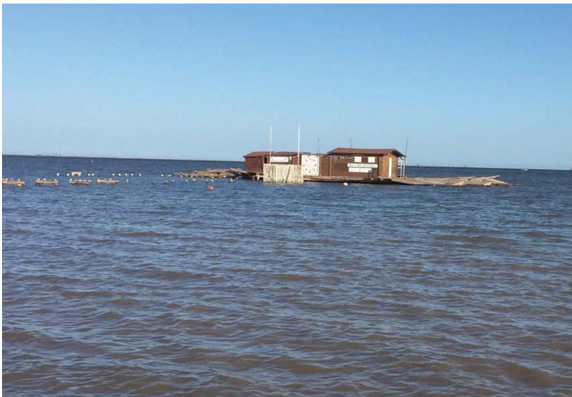
IMÁGEN 14. Fotografía tomada in situ el 08/10/2019.
