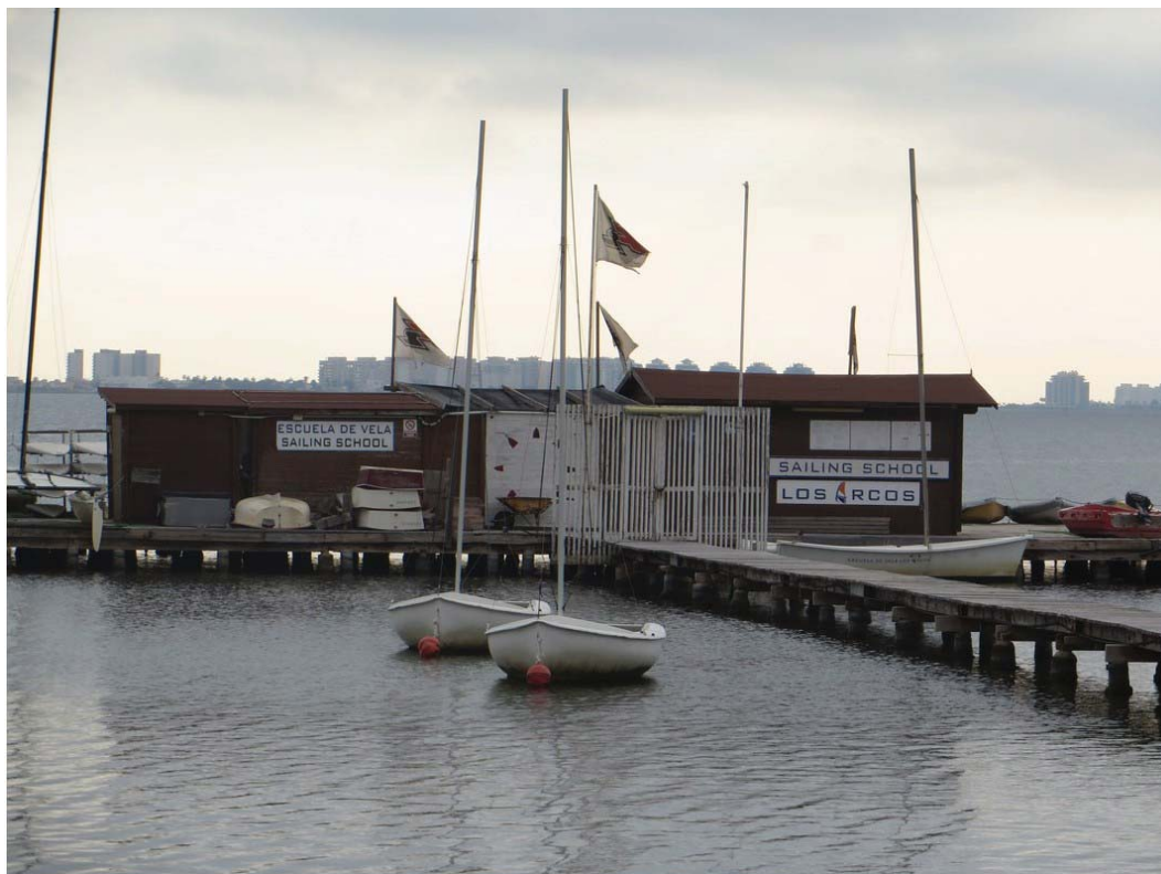
IMÁGEN 16 Fachada del balneario.
