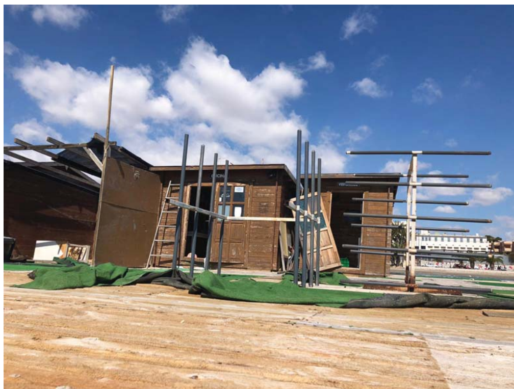
IMÁGEN 16. Fotografía tomada in situ el 08/10/2019.
