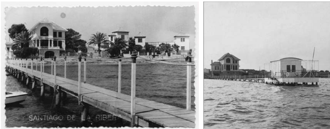
IMAGEN 1. Fotos del balneario original.
