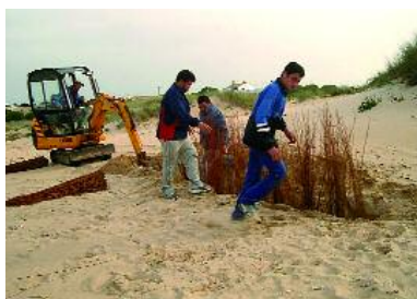
Foto 6.8. Instalación de los captadores. Apertura de zanja y colocación.
