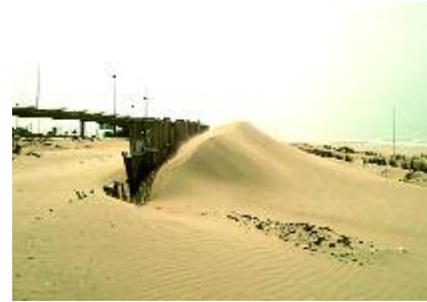
Foto 6.9. Efecto de las tablestacas.
