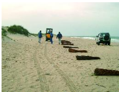
Foto 6.7. Instalación de los captadores. Distribución sobre el terreno.
