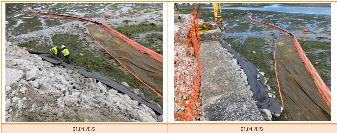
Figura 8 Empleo de geotextil en frente de avance.
