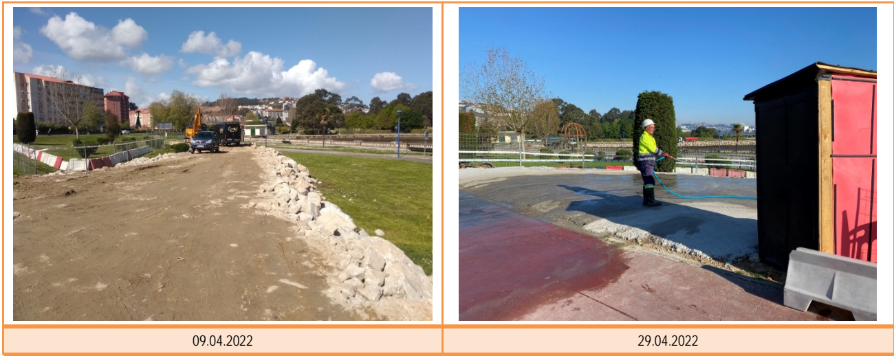
Figura 3 Ejemplos de riegos de vial en viales de obra.
