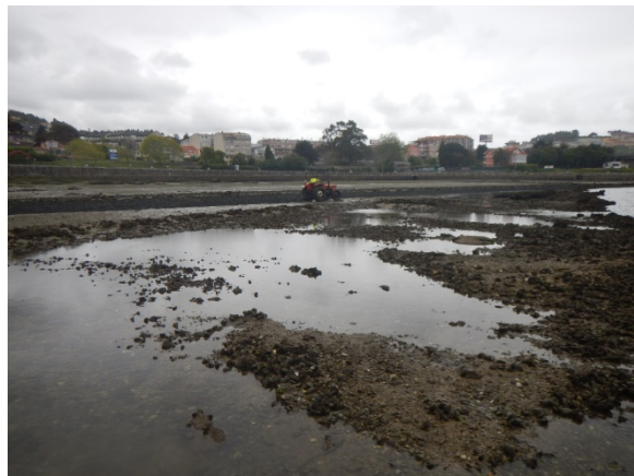
18.04.2022. Preparación de terreno para recolocación.
