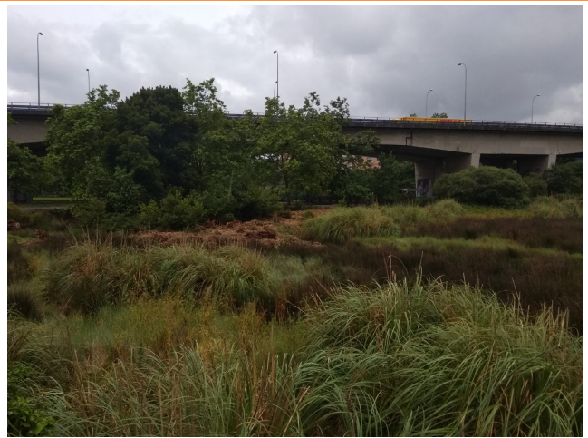
31.05.2022. Labores de desbroce
