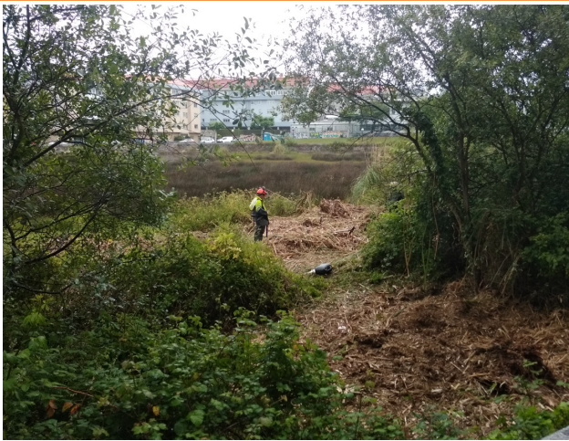
31.05.2022. Labores de desbroce
