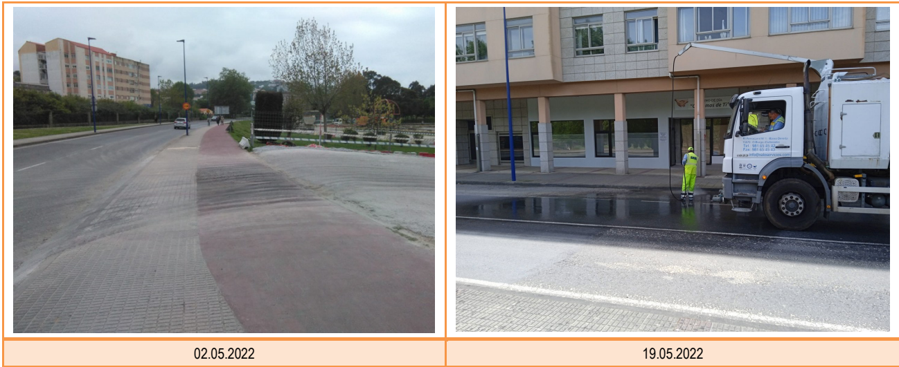
Figura 3 Ejemplos de riegos de vial en viales de obra y acceso
