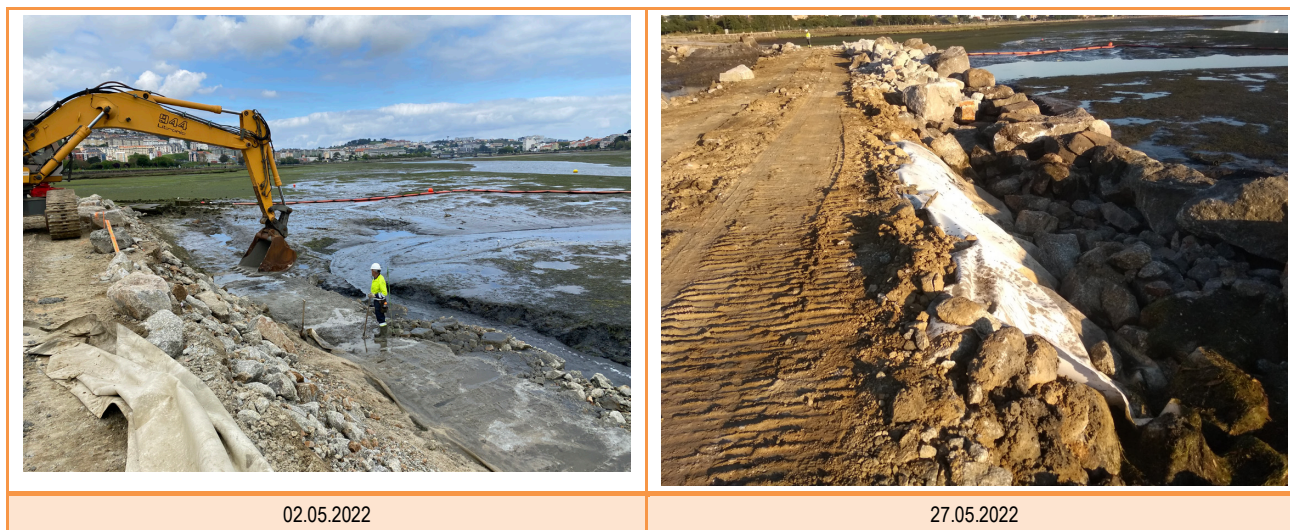
Figura 8 Empleo de geotextil en frente de avance.
