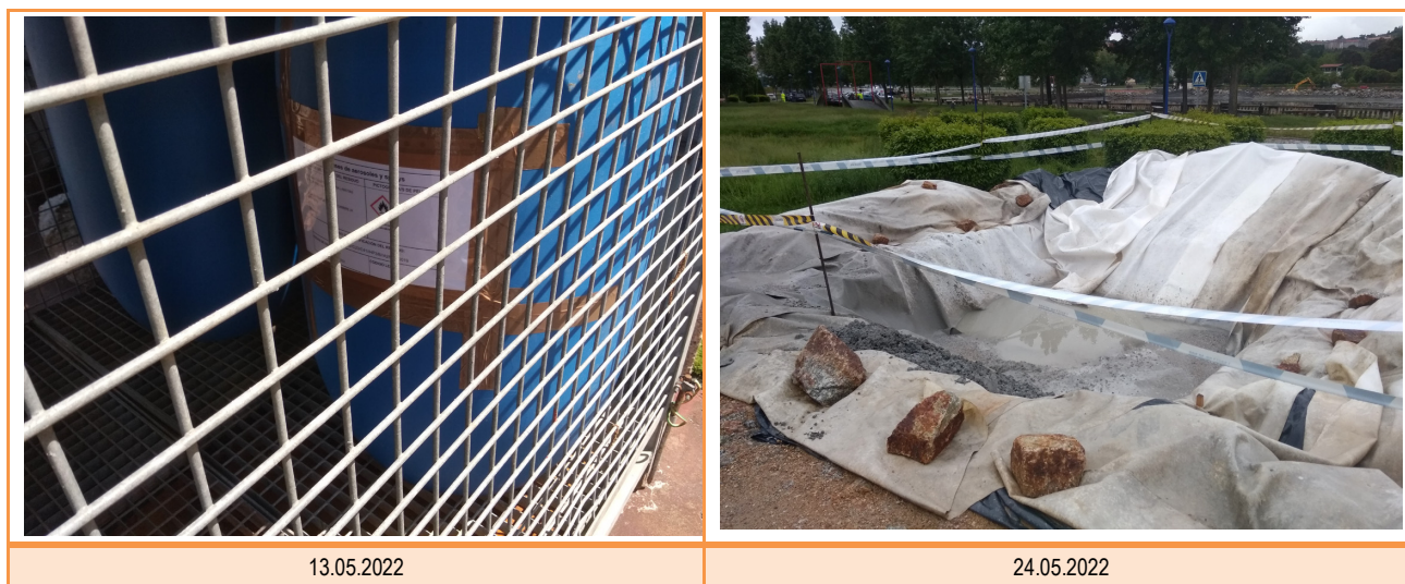
Figura 9 Contenedor de residuos peligrosos y zona de lavado de hormigoneras
