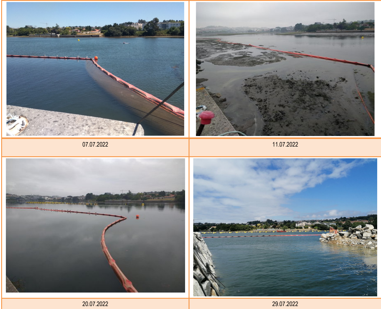
Figura 7 Seguimiento de la barrera antiturbidez.
