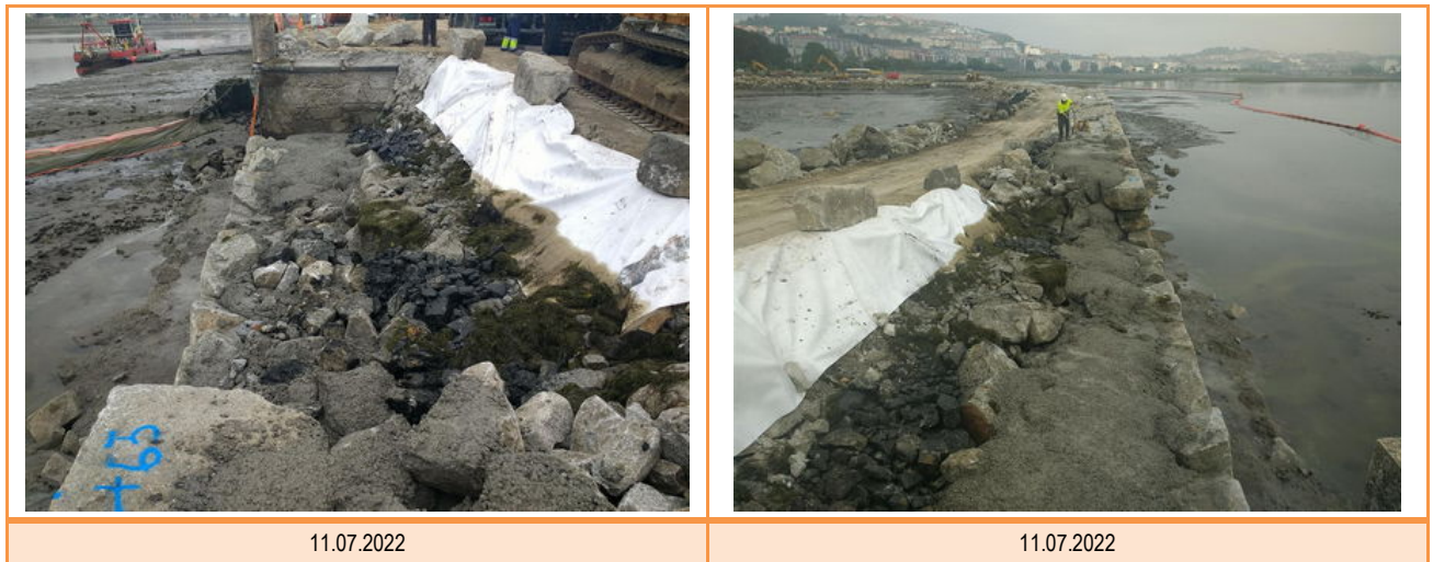
Figura 8 Empleo de geotextil en frente de avance.
